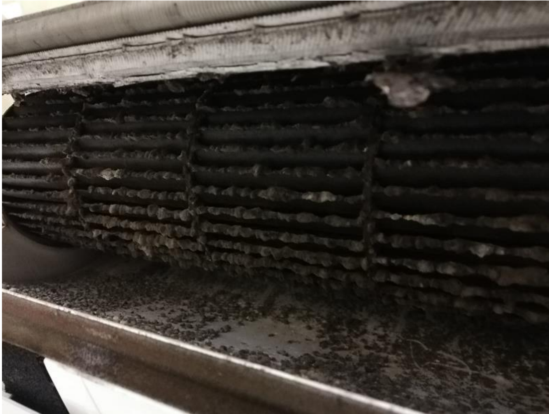
Kuva 6. Likainen puhallin (13).
