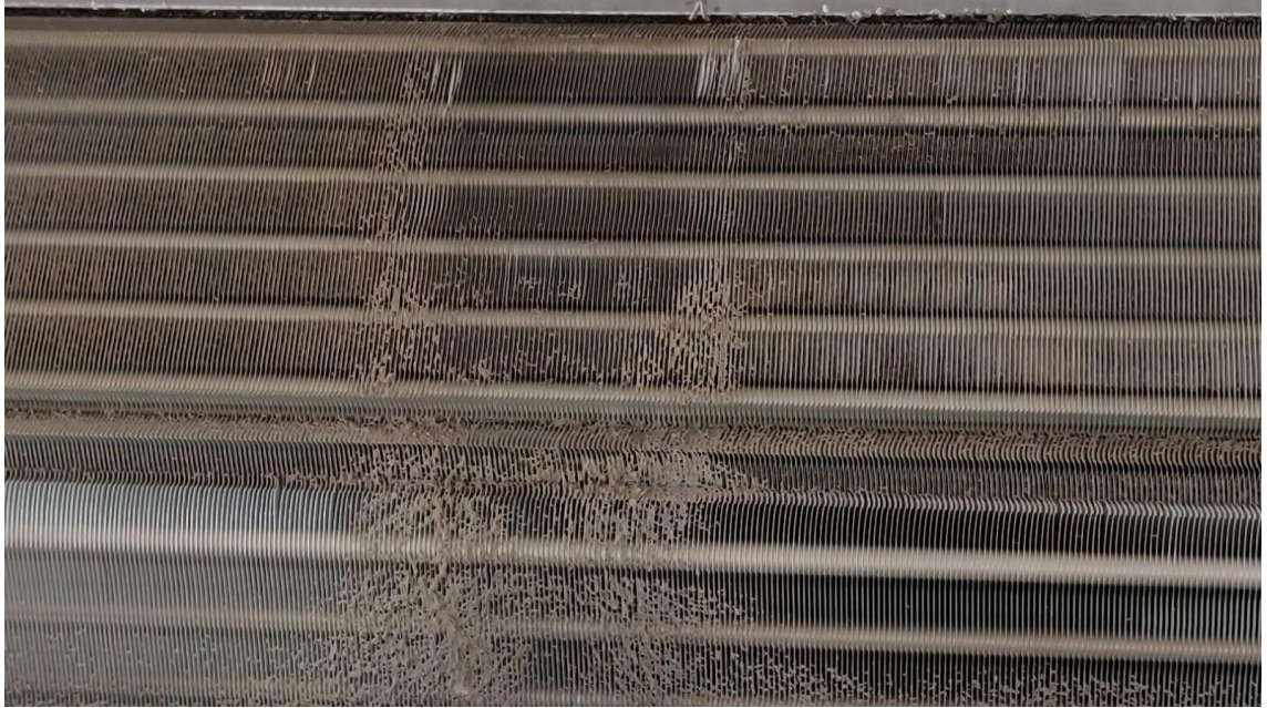
Kuva 14. Omakotitalon sisäyksikön likainen kenno.
