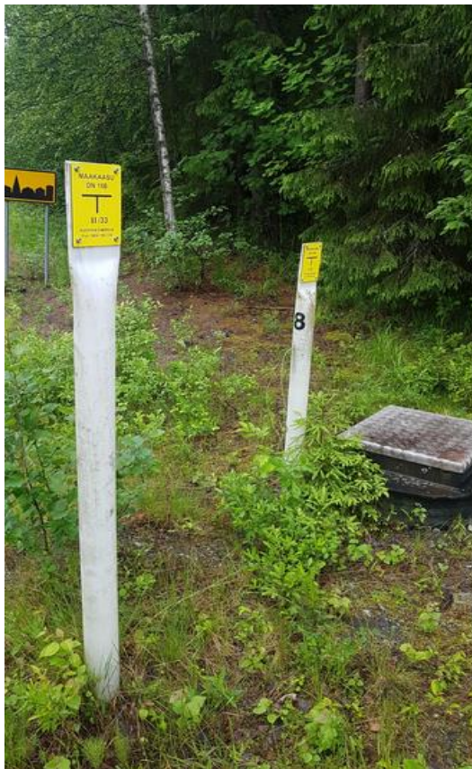
KUVA 21. Maakaasuputken merkkikeppi maastossa. (Holopainen)
