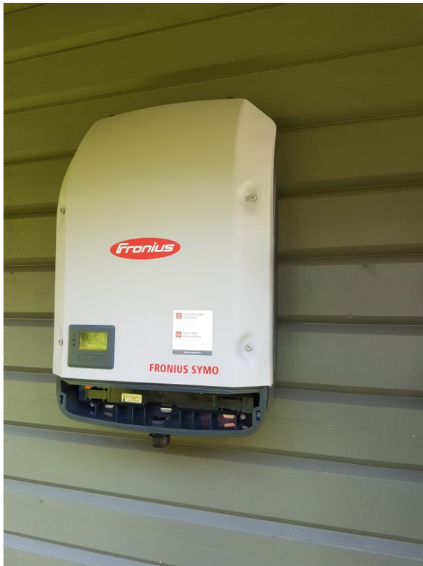
Kuva 9. Vaihtosuuntaaja eli invertteri asentamattomana.
