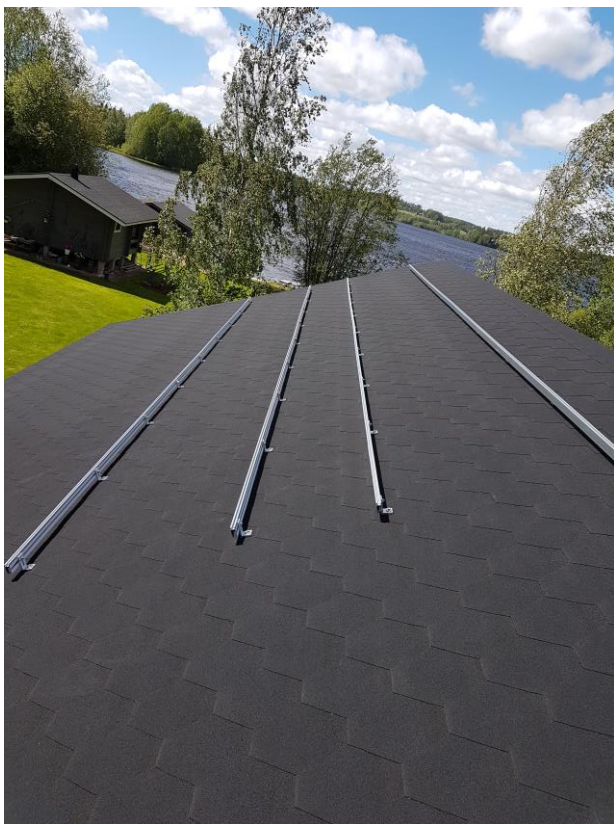
Kuva 12. Kattokiinnikkeet ja alumiinikiskot asennettuna.
