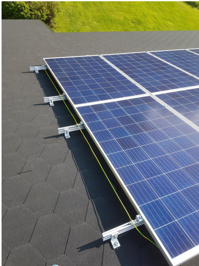
Kuva 14. Maadoitusjohto ja maadoituskorvikkeet.
