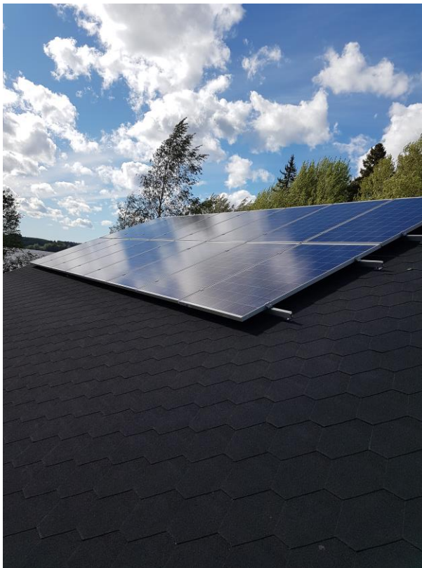
Kuva 13. Aurinkopaneelit asennettuna kiskoihin.
