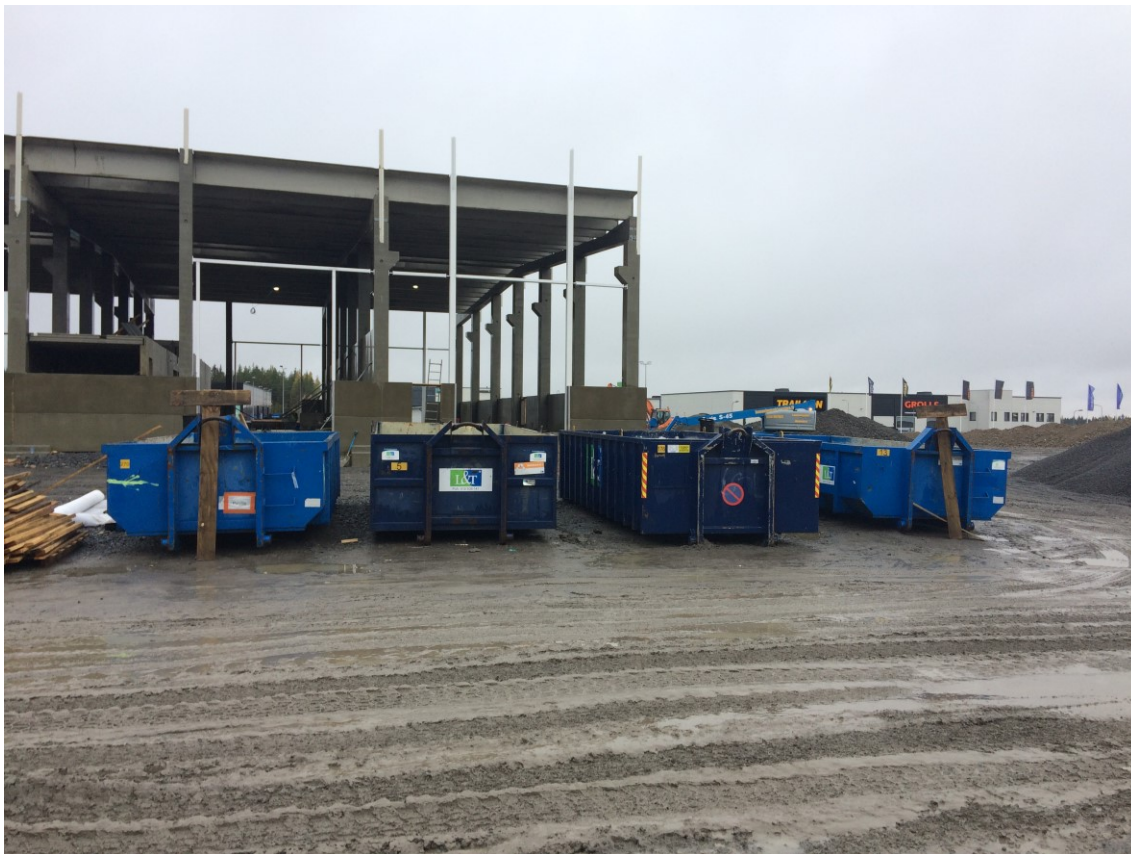
KUVA 6. Runkovaiheessa olevan hallityömaan jätteidenkeräyslavat: puujäte, energijäte, metallijäte ja rakennusjäte
