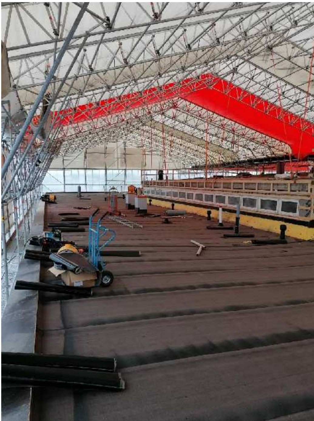
Kuva 6. Turvallinen ja siisti työmaa. Kermin asennus hitsaamalla meneillään. Sääsuojan yhteydessä kulkutie ja kaiteistus. Työvaiheeseen kuulumattomat tavarat siivottu pois.
