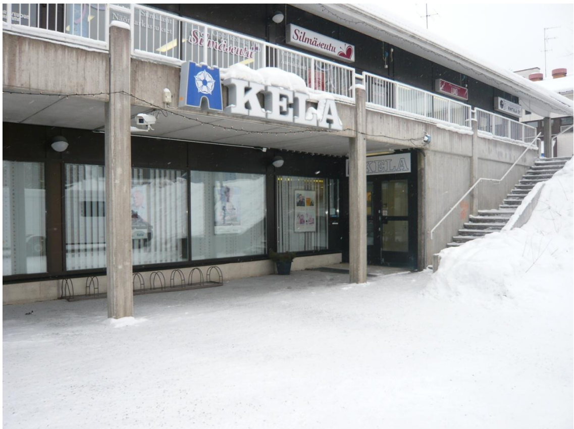
Kuva 1. Alajärven Kelan julkisivu.
