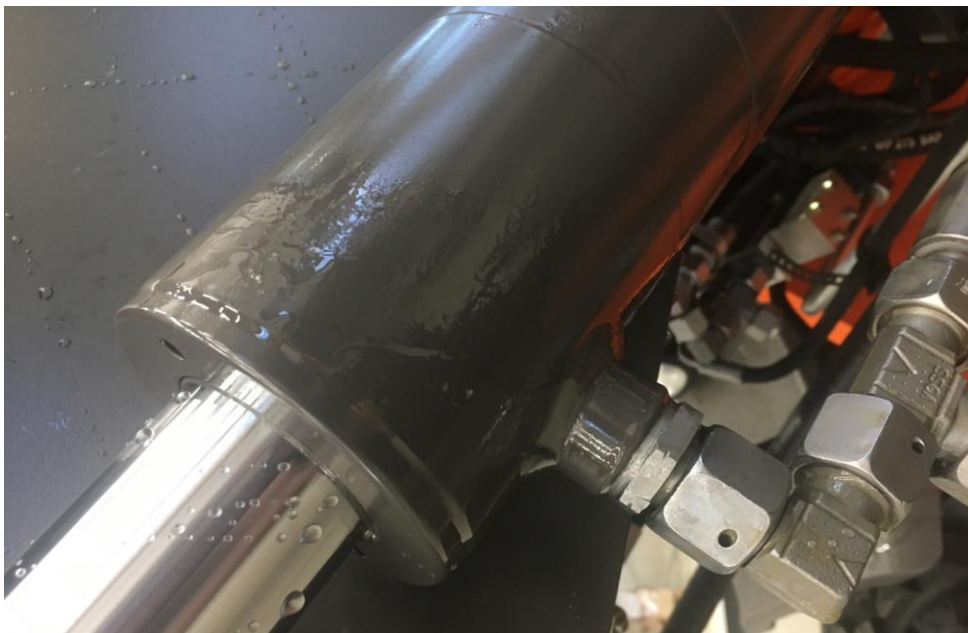
Kuva 13. Kuva vuodosta ennen korjauksen aloittamista.
