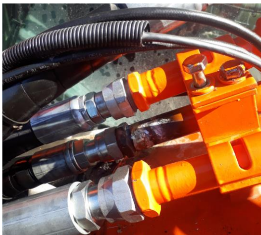
Kuva 12. Korjauksen jälkeinen kuva.
