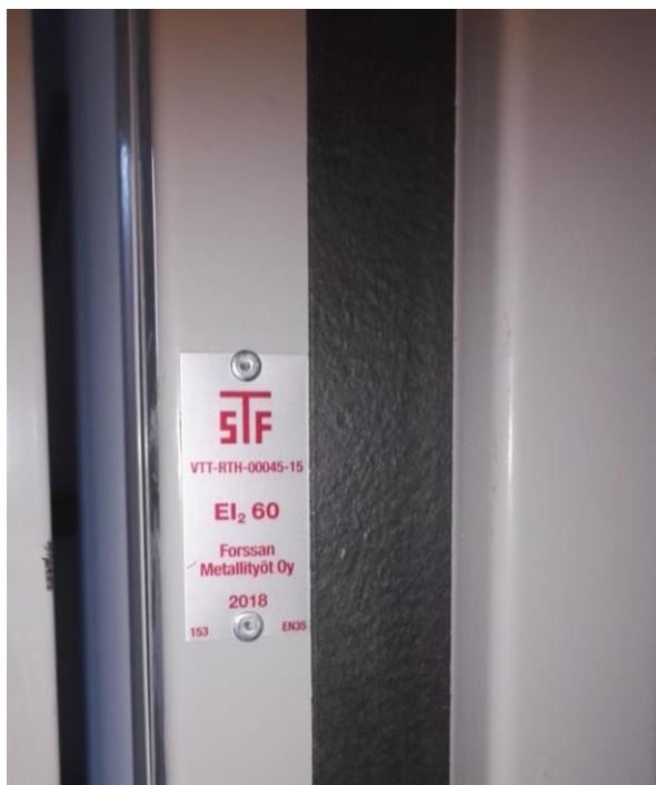
Kuva 3. Metallipalo-oven tyyppihyväksyntä. Kyseistä ovea voidaan käyttää EI120-paloluokan aukossa.
