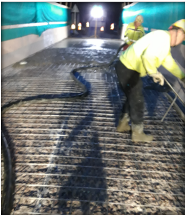
Kuva 31. Betonin tasausta tärypalkilla.
