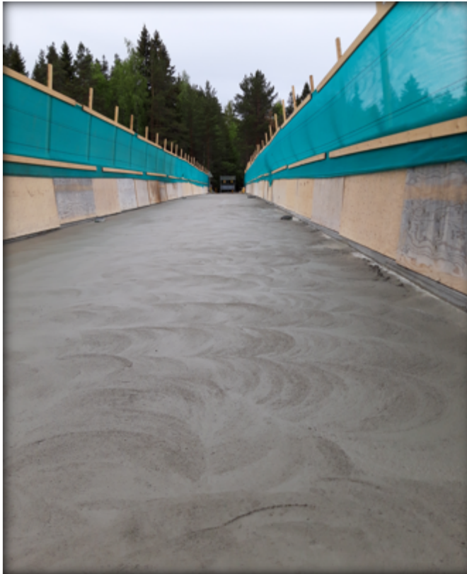
Kuva 32. Betonin hietotyö suoritettu kohteessa
