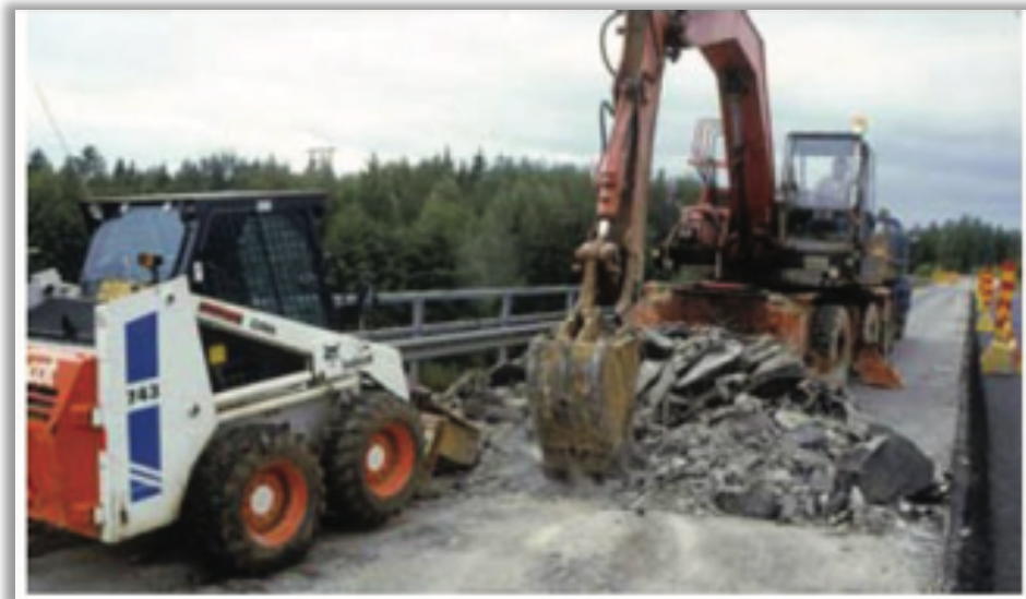
Kuva 5. Vanhan eristyksen poistoa kaivinkoneella. [5].
