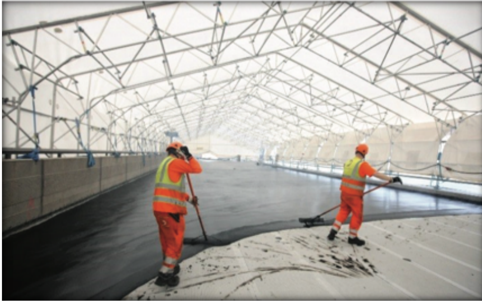
Kuva 11. Eristysmastiksin levitystä sääsuojan alla. [5].
