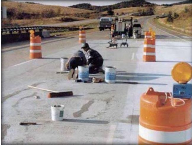
Kuva 22. Kuvassa betonipäälysteisen sillankorjausta Xypexin tuotteilla. [20].
