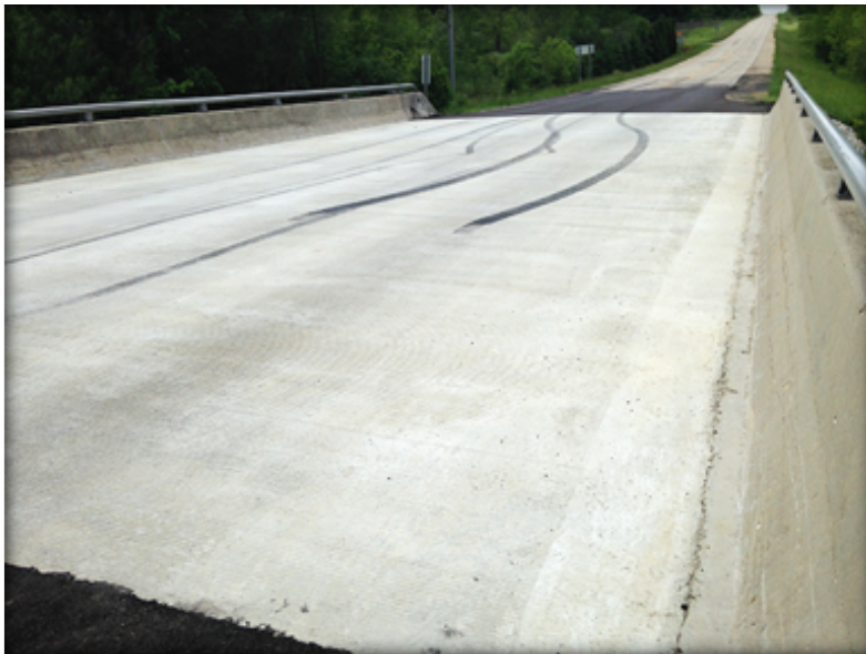
Kuva 23. Sillan betonikansi korjattu vesitiivistetyllä betonilla. [20].
