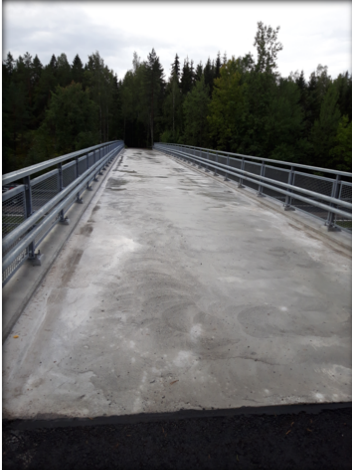
Kuva 36. Vesterängin risteyssillan korjattu betonipäällyste.
