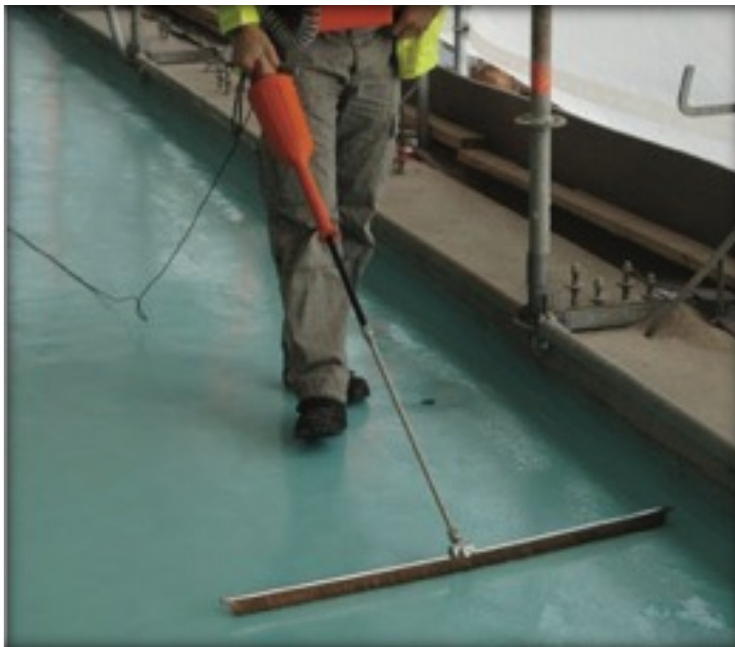
Kuva 8. Valmiin epoksi tiivistystyksen tiiveys mitataan kipinäharavalla [9]
