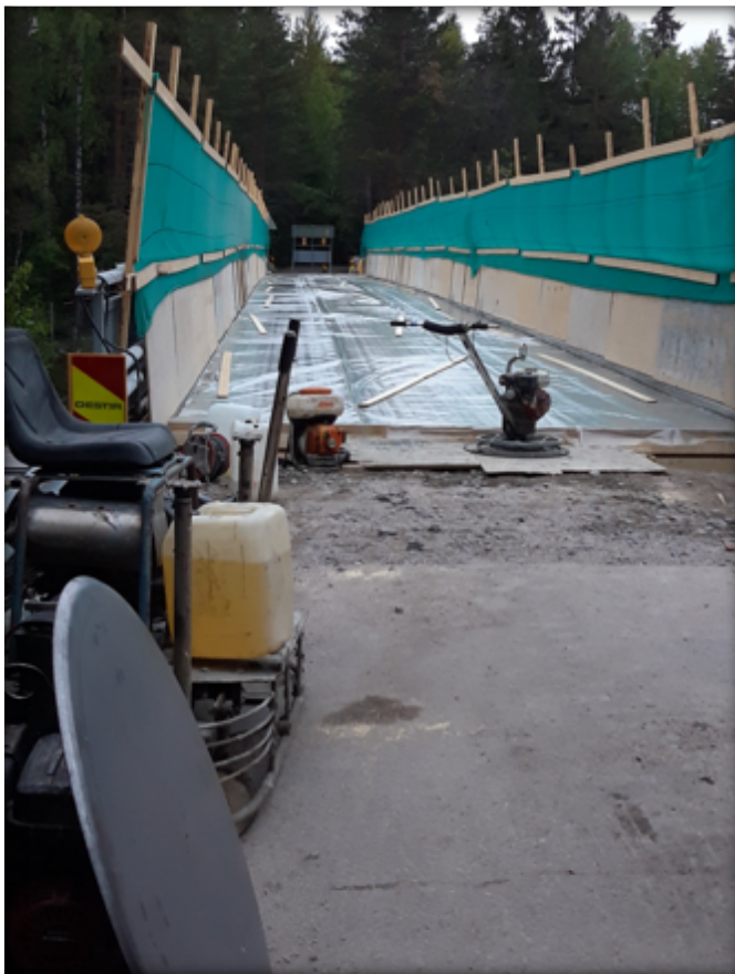
Kuva 33. Hierretty betonipinta peitetty muovilla.
