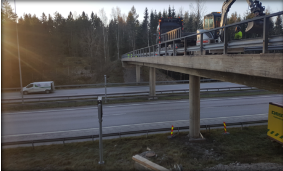
Kuva 28. Pintarakenteiden purkua kaivinkoneella.
