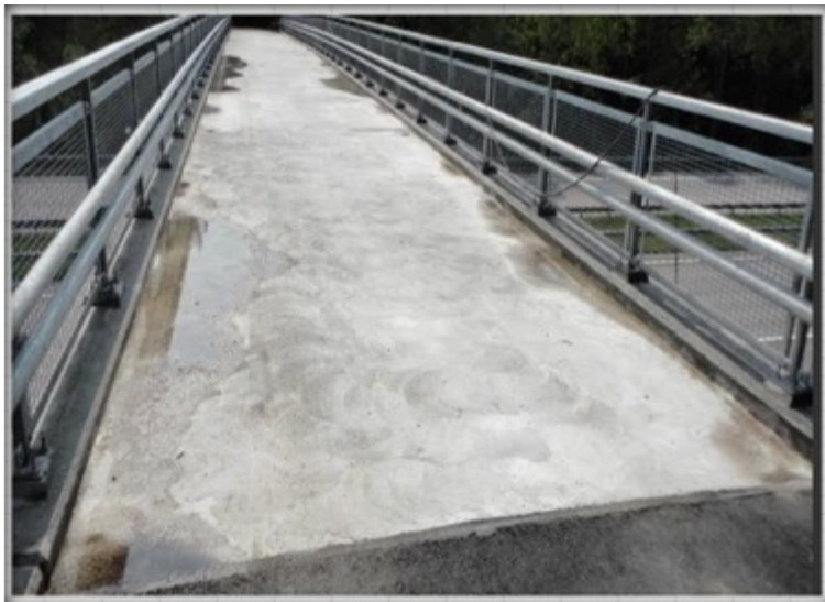
Kuva 35. Vesterängin risteyssillan uusi betonipäällyste ensimmäisen sateen jälkeen. [22].
