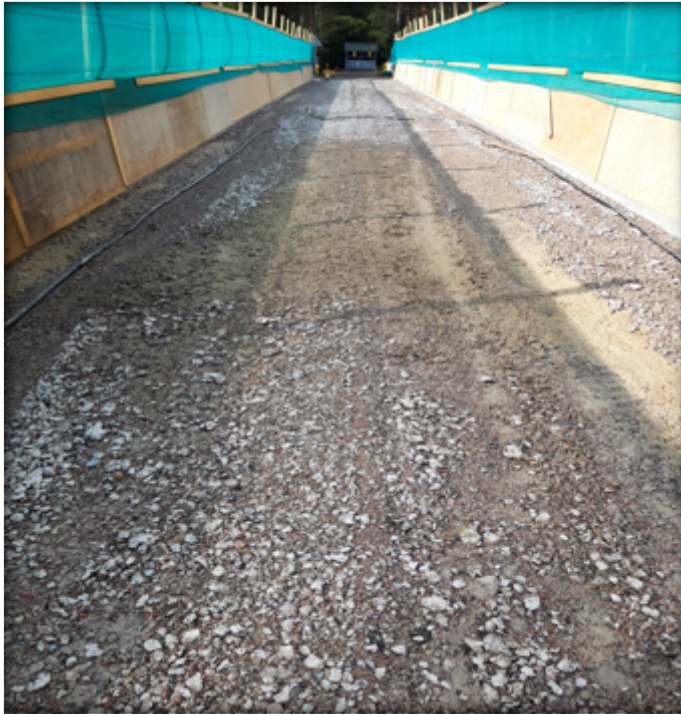
Kuva 30. Kansi vesipiikkauksen jälkeen.
