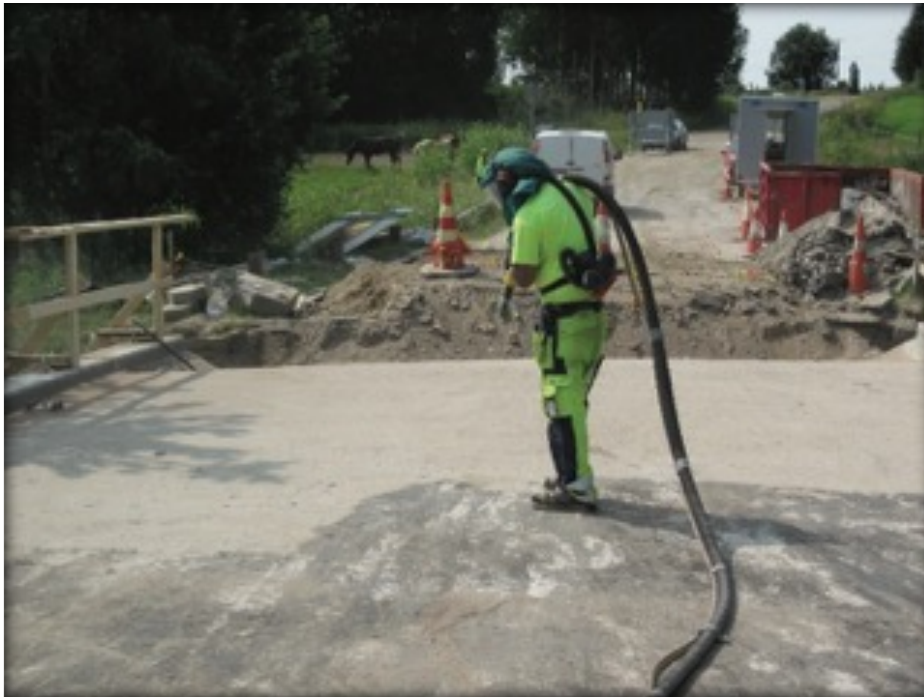
Kuva 6. Bitumi- ja mastiksijäämien poistoa hiekkapuhaltamalla [5]
