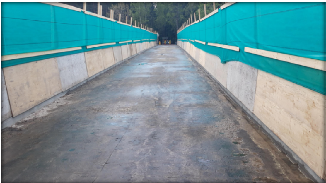
Kuva 29. Sillan betoninen kansilaatta pintarakenteiden purun jälkeen.
