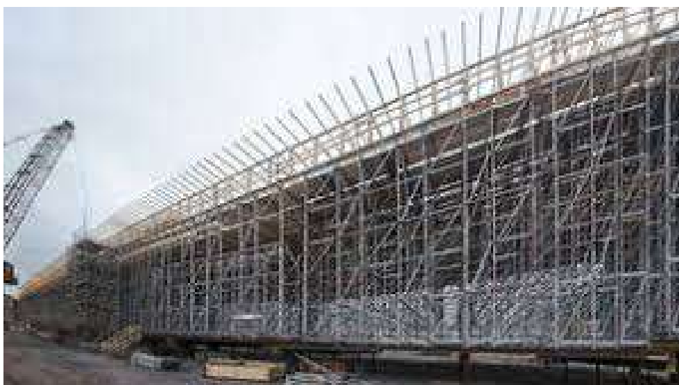
KUVA 5, Telinekatajan terästelineet Pasilan sillan tukitelineenä (Telinekataja.fi)
