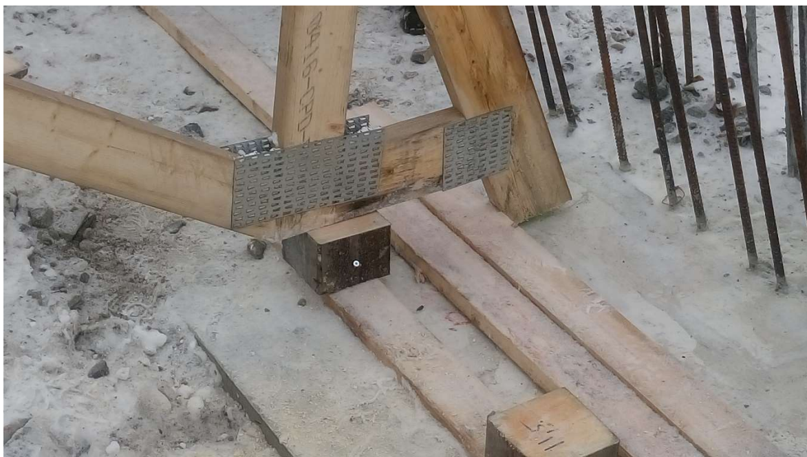
KUVA 12, Ristikko nostettuna pystytuen päälle (Niskanen 2018)
