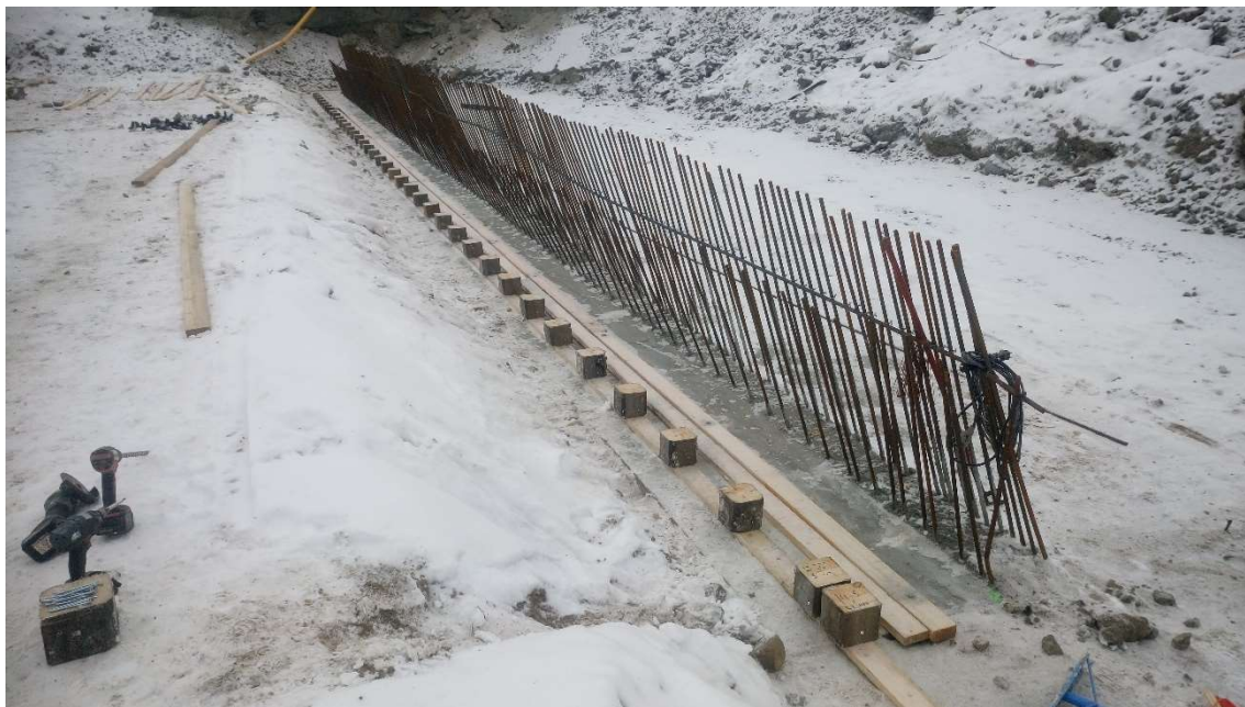
Kuva 9, Naulalevyristikoiden asennusta valmistelevien töiden tulosta ja anturan tartuntateräkset (Niskanen 2018)
