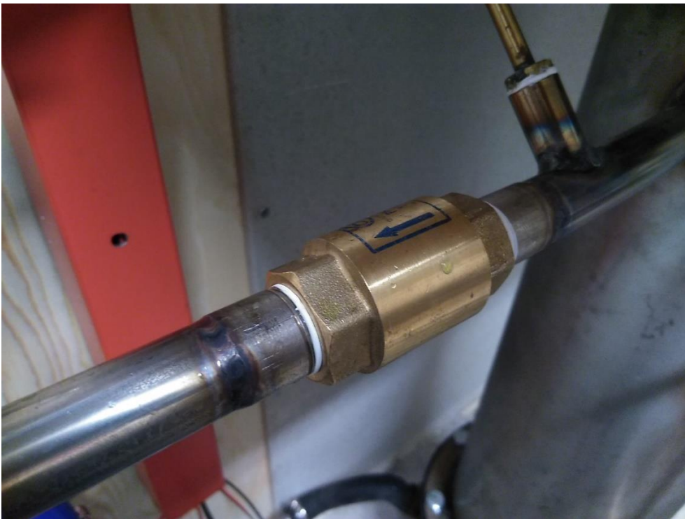
KUVA 66. Lauhduttimen takaiskuventtiili
