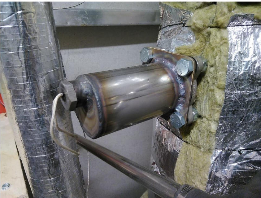
KUVA 64. Kattilan pinta-anturi
