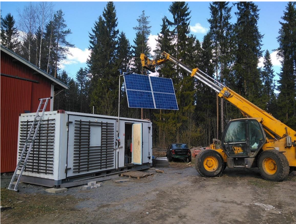
KUVA 75. Valmiin paneeliston nosto paikoilleen kurottajalla
