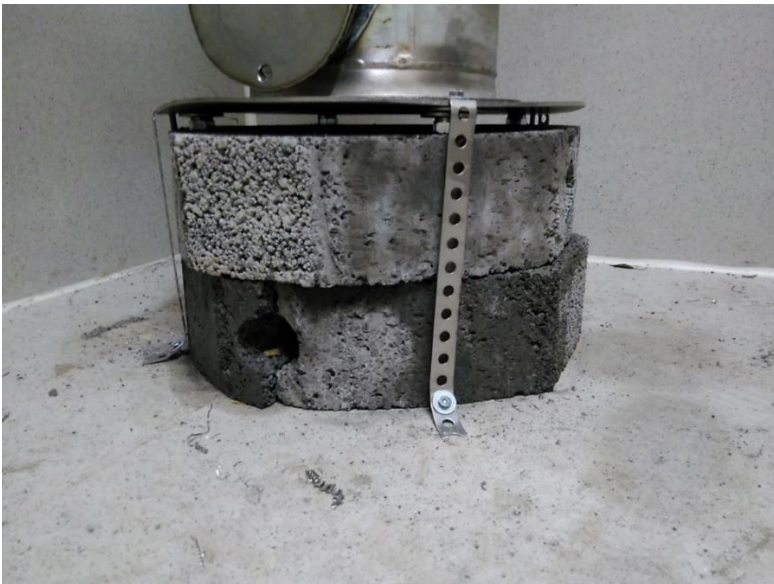
KUVA 55. Tulenkestävä ja eristetty jalusta
