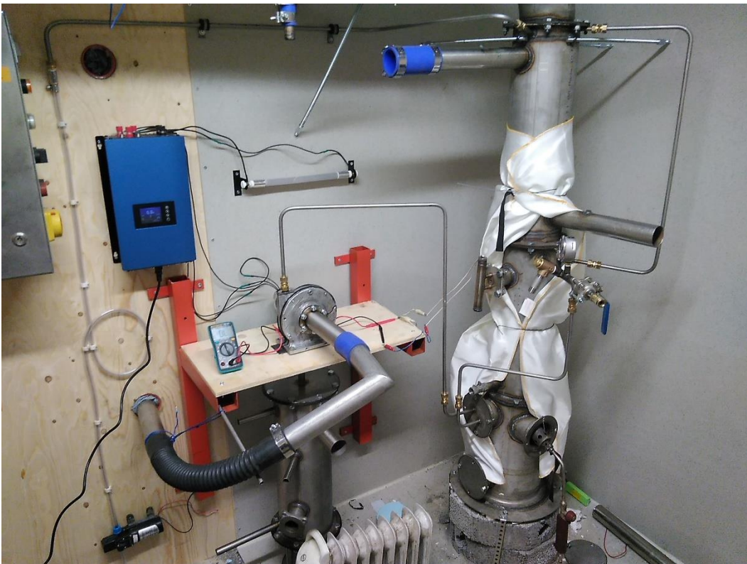
KUVA 77. Vesi- ja höyryputkitukset valmiina ensimmäiseen testiajoon
