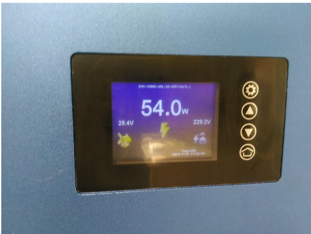
KUVA 81. Invertterin tehon mittaus
