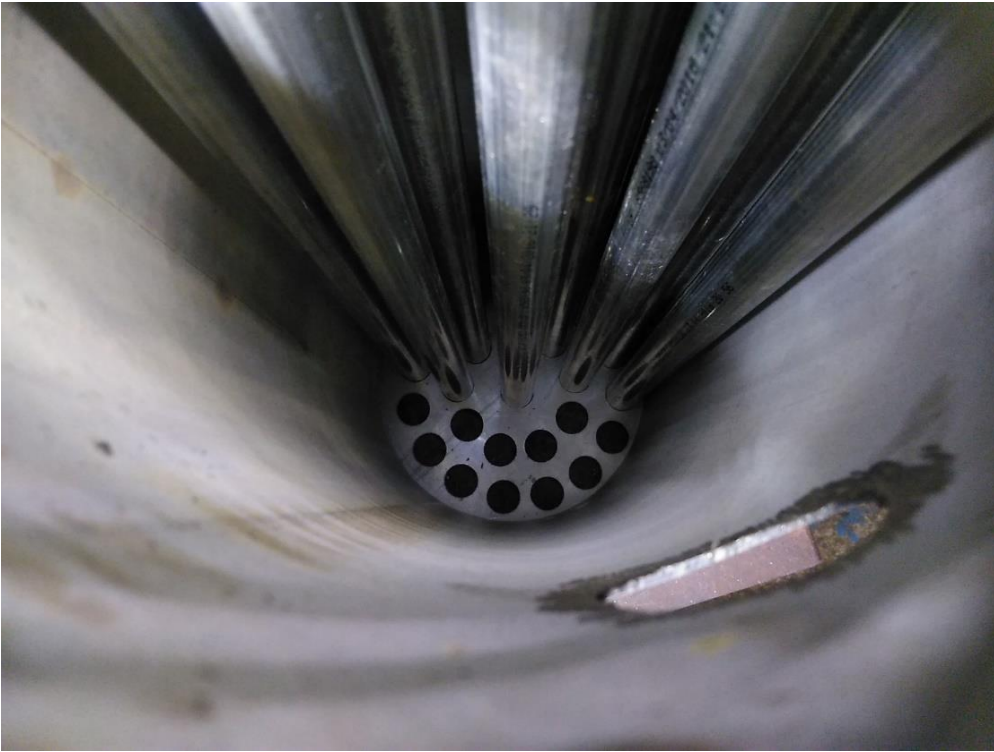
KUVA 50. Lämmönvaihdin sisältä, puolet putkista paikoillaan
