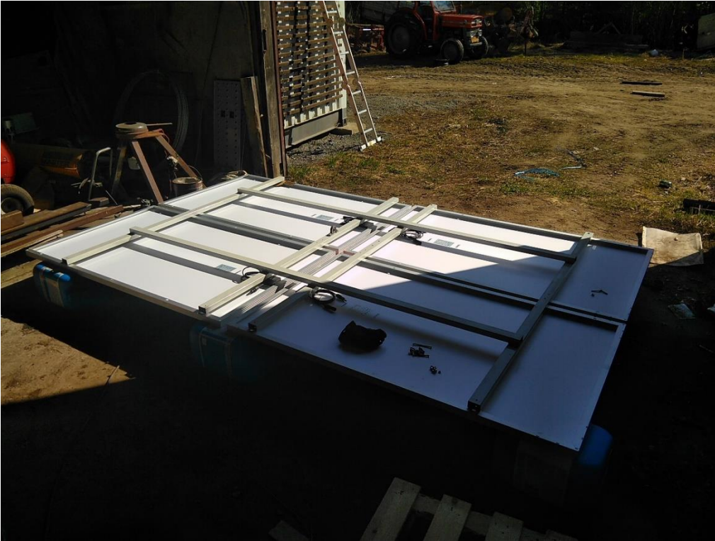
KUVA 74. Paneelien kiinnitys apurunkoon maassa
