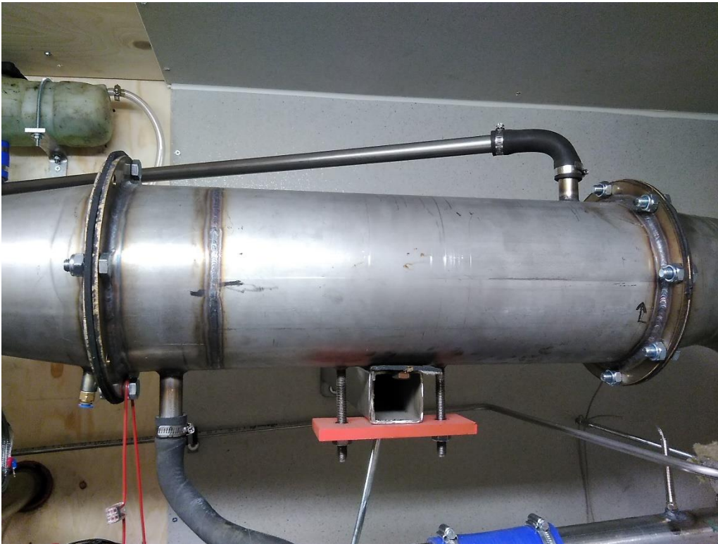
KUVA 68. Savukaasu-vesi lämmönvaihdin
