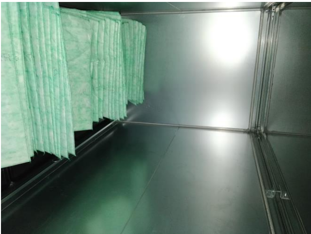
KUVA 6 Puhdistettu ilmanvaihtokoneen suodatinkammio
