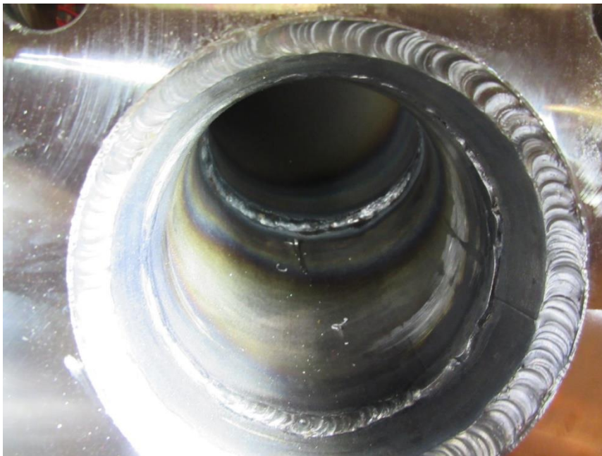
Kuva 16. Vesiputken sisällä olevia epäpuhtauksia.
