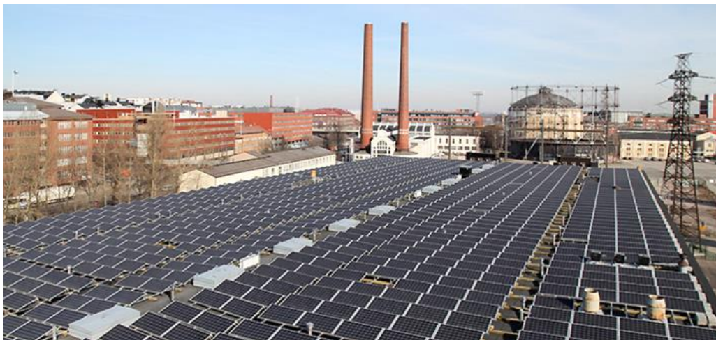
Kuva 6. Helsingin Suvilahdessa sijaitseva aurinkovoimala. [67.]
