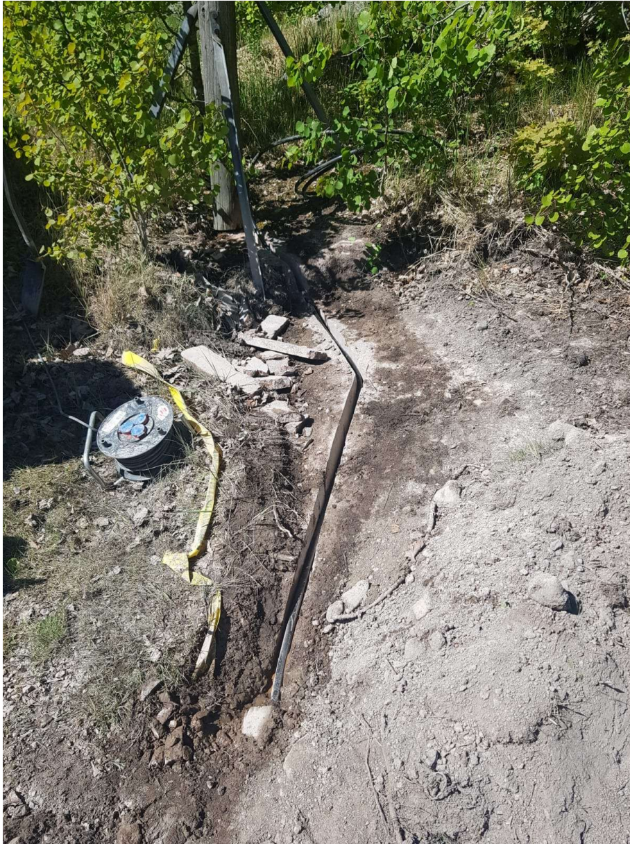
Kuva 6. Kaapeli asennettu pinta kallioon. Ura kaapelille sahattu kivisahalla. (Nieminen 2018)
