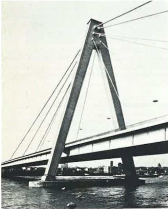
Kuvio 1. Vinoköysisilta Severinsbrücke Reinin yli Kölnissä 1958
