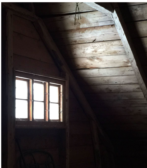
KUVA 8 Ullakon yläikkunat (Villa Eevilän valokuva-arkisto)
