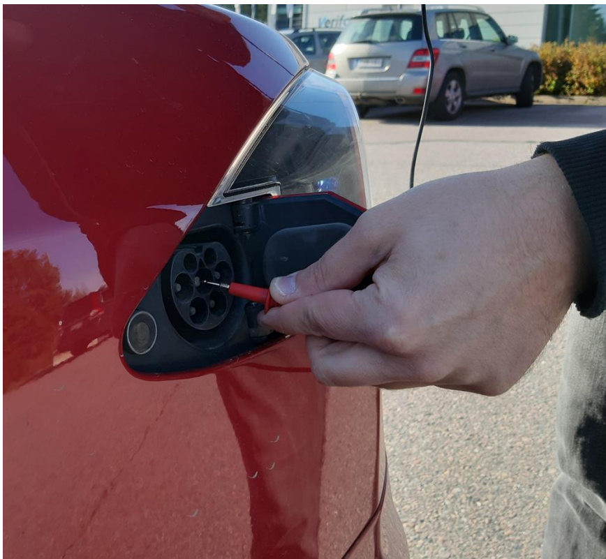
Kuva 5. Suojajohdinpiirin jatkuvuuden tarkastaminen.
