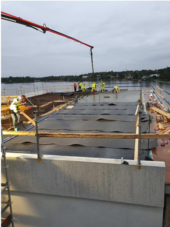
Kuva 11. Holvin valu ja peittely käynnissä (Komminaho 19-09-2019)
