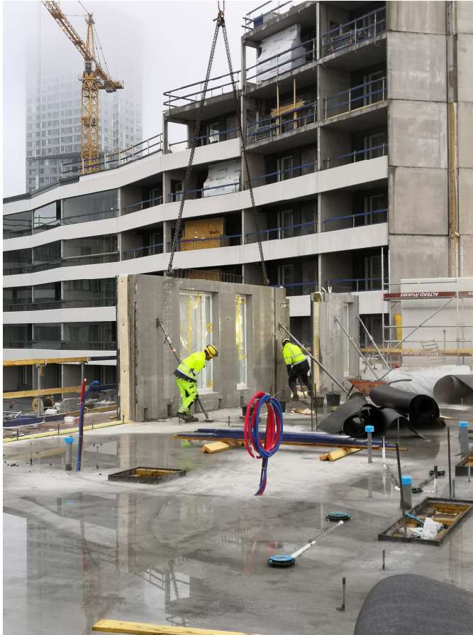
Kuva 5. Elementtiasennus käynnissä (Komminaho 25-09-2019)
