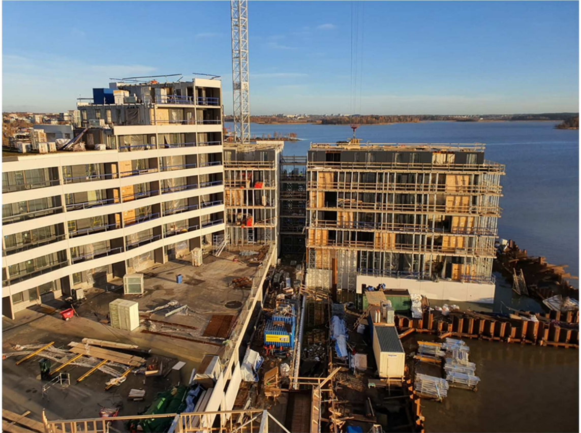
Kuva 19. Rungossa 6.kerrosta valmiina.
