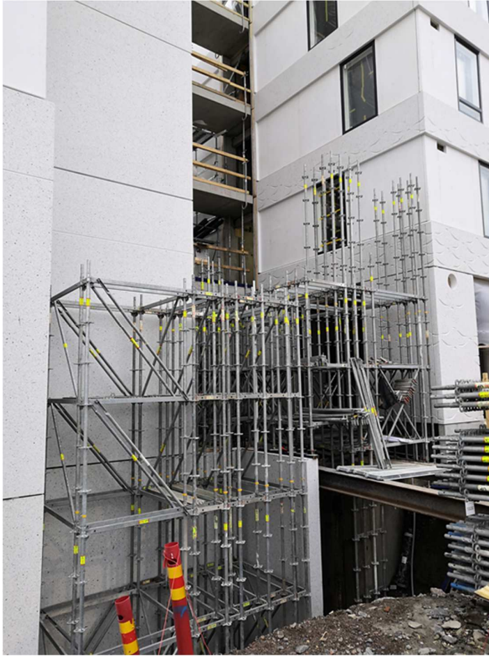
Kuva 20. Tukitornien rakentamisen ensimmäinen vaihe
