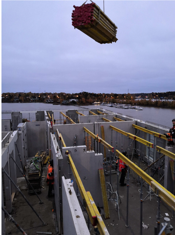
Kuva 7. Holvin rakentaminen käynnissä (Komminaho 16-10-2019)
