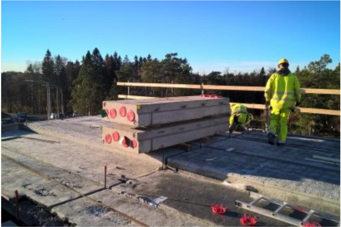
Kuva 2. Hormielementtejä työmaalla (Lujabetoni Oy:n verkkosivut)
