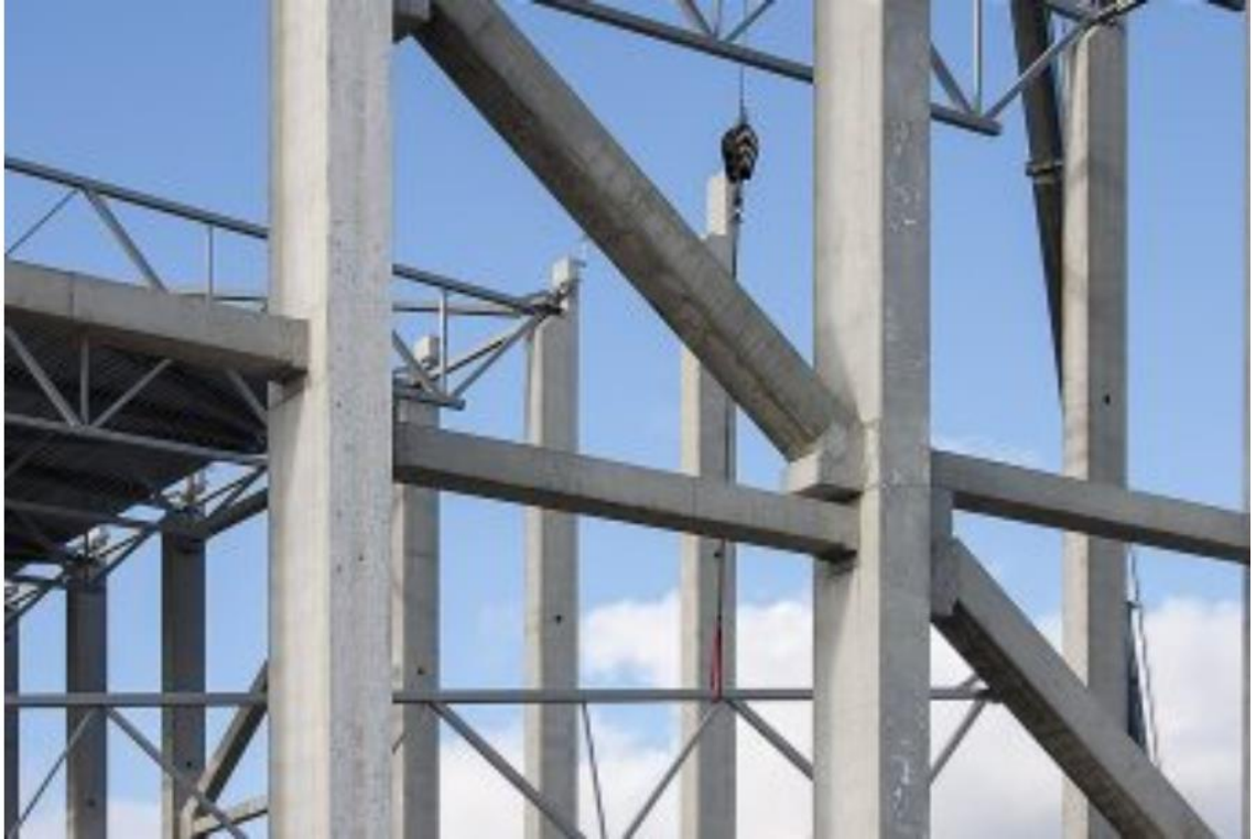
Kuva 1. Pilareita ja palkkeja (Lujabetoni Oy:n verkkosivut)
