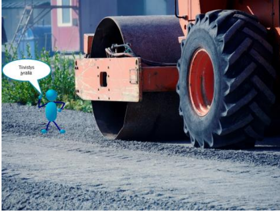
KUVA 9. KANTAVAN KERROKSEN TIIVISTYS JYRÄLLÄ.
