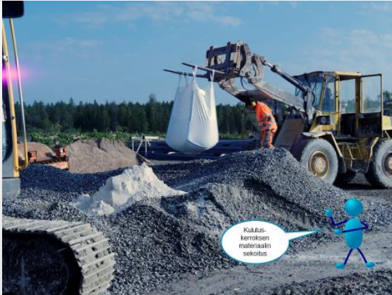
KUVA 10. KULUTUSKERROSMATERIAALIN SEKOITUS JA KASTELU.
