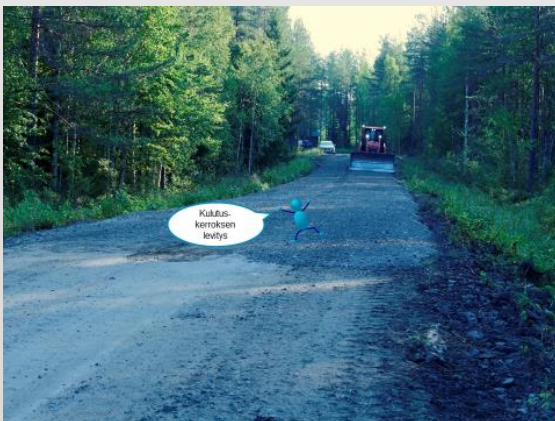
KUVA 11. KULUTUSKERROKSEN LEVITYS KANTAVAN KERROKSEN PÄÄLLE.
