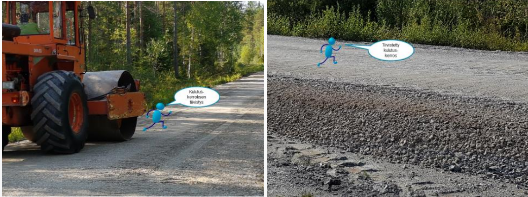
KUVA 11. KULUTUSKERROKSEN TIIVISTYS JYRÄLLÄ.
