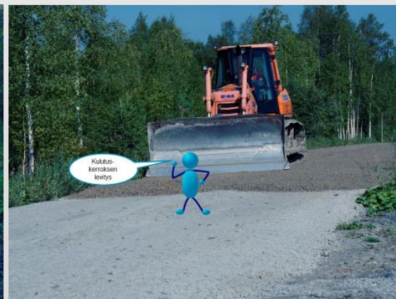
KUVA 11. KULUTUSKERROKSEN LEVITYS KANTAVAN KERROKSEN PÄÄLLE.
