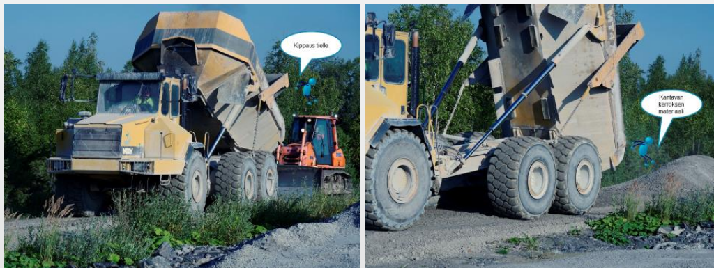
KUVA 7. KANTAVAN KERROKSEN MATERIAALIN PURKU TIELLE.
