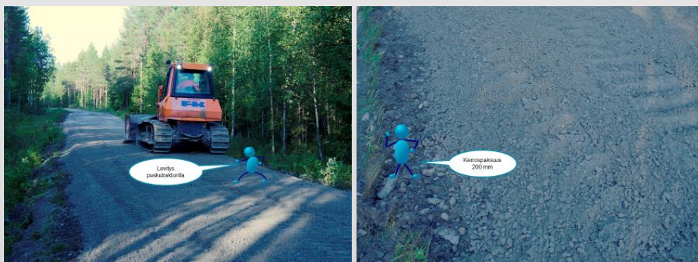
KUVA 8. KANTAVAN KERROKSEN MATERIAALIN LEVITYS KORJATAVALLE TIEOSUDELLE.
