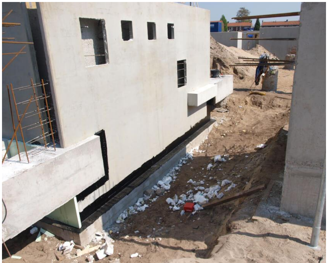
Kuva 12. Vasemmalla näkyy hieman XPS-levyllä suojattua ruiskukumia, joka jää täyttövaiheessa maan alle. (LiquidRubber Europe, n.d.)
