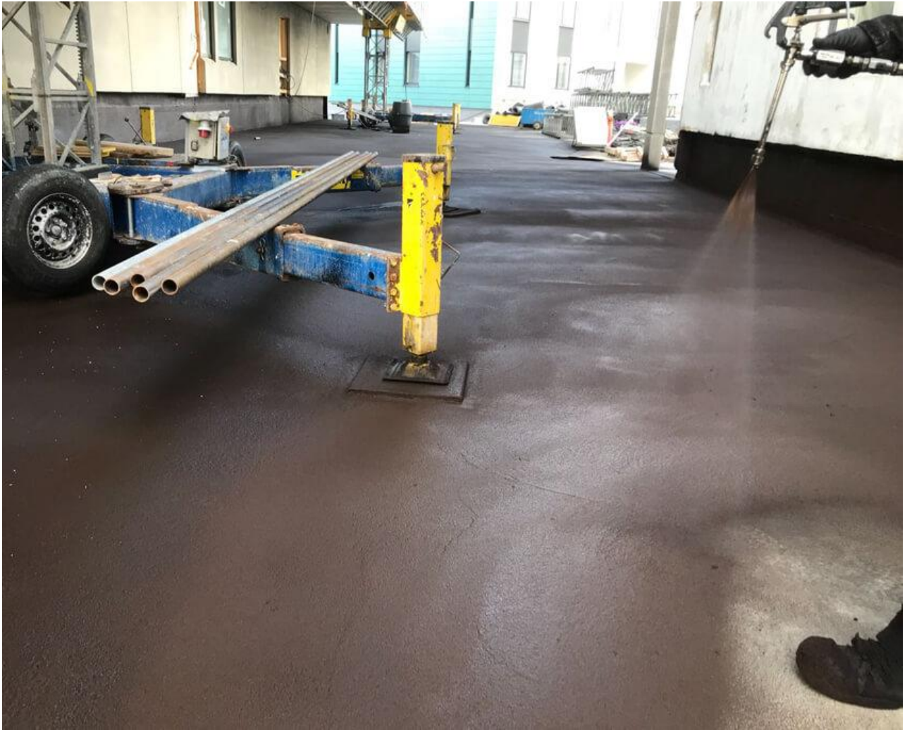
Kuva 9. Ruiskukumin asennusta pihakannelle Tikkurilan kohteessa. (Ruiskukumi oy, n.d.)
