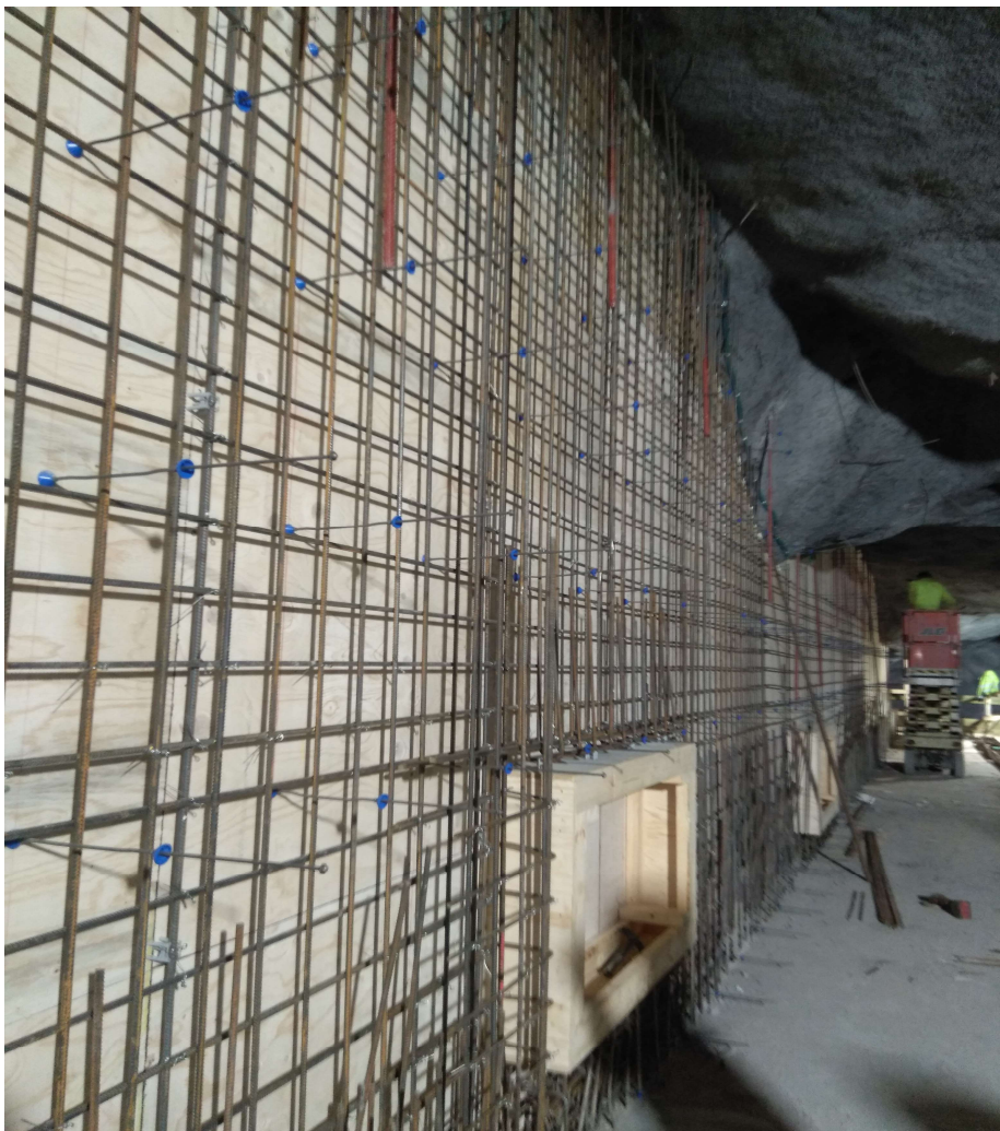
Kuva 7. Kaitaan metroaseman työseinän muotti ja rauditus.
