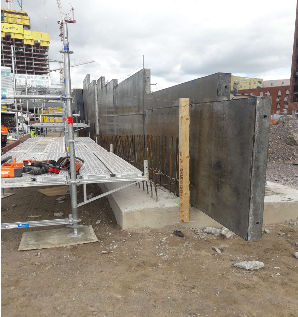
Kuva 12. Kalasataman puiston paikallavaluseinän muotti.
