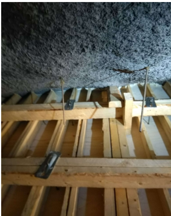
Kuva 8. Kaitaan metroaseman kallion ja muotin liitos.
