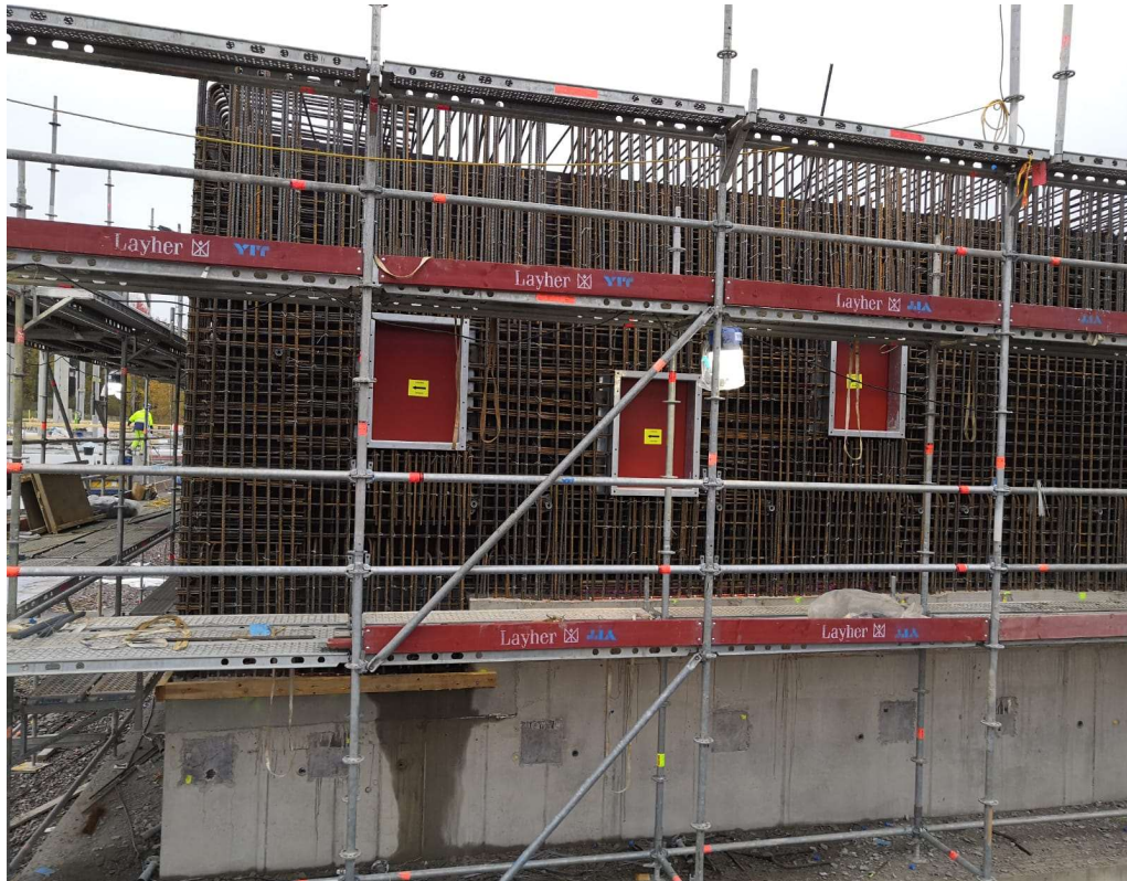
Kuva 17. Väestönsuojan pakoluukku kalusteet.
