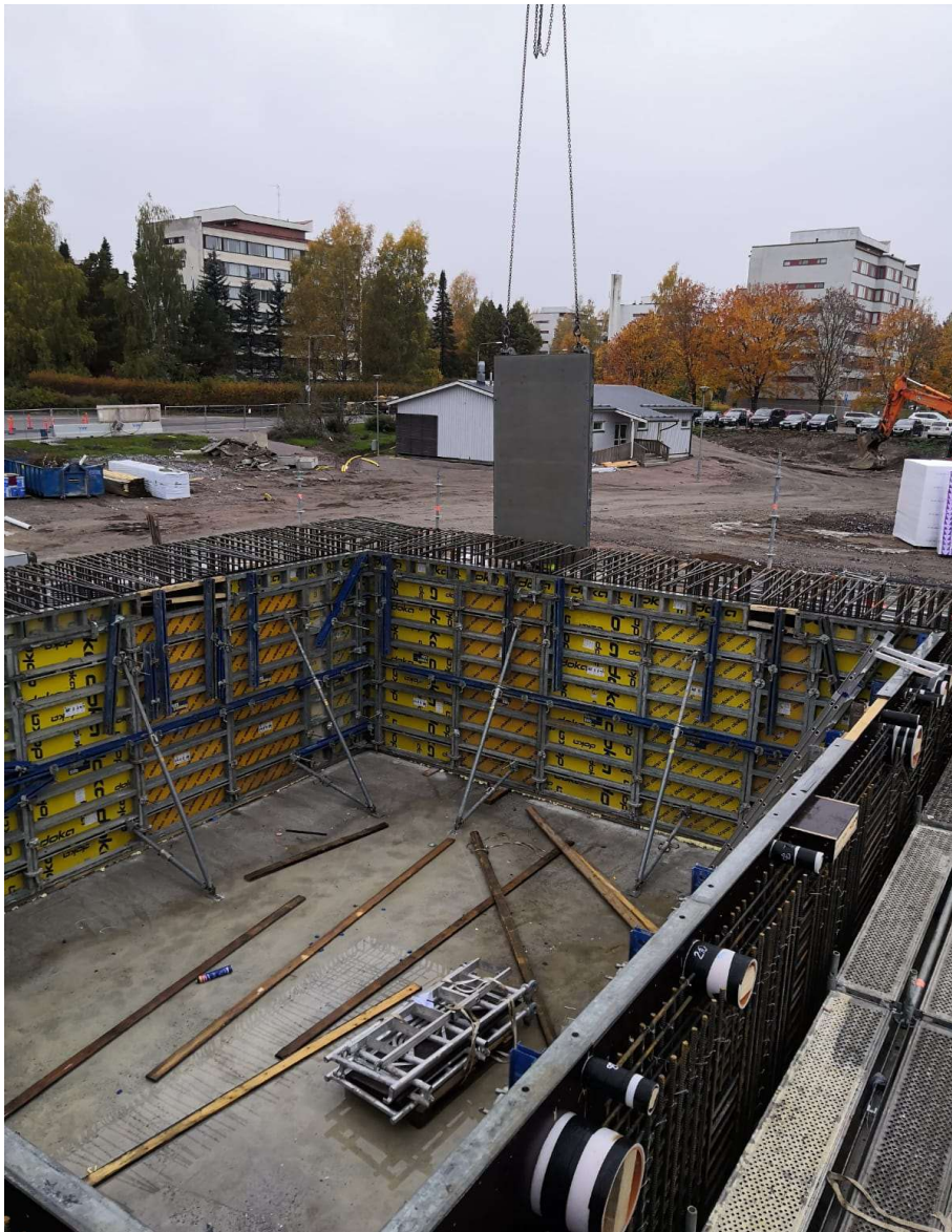
Kuva 2. Framax Xlife -suurmuotti ja suurmuottitarvikkeet, Keravan monitoimitalo.
