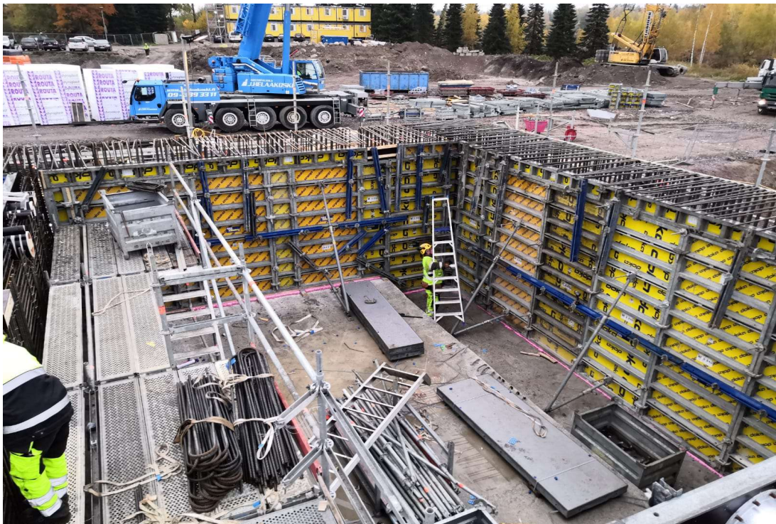
Kuva 16. Väestönsuojan suurmuotin pystytys.
