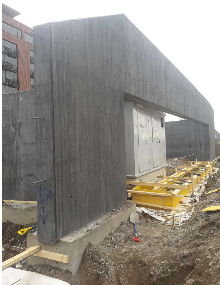
Kuva 11. Kalasataman puisto. Suurmuotti ja lautapintaverhoilu.
