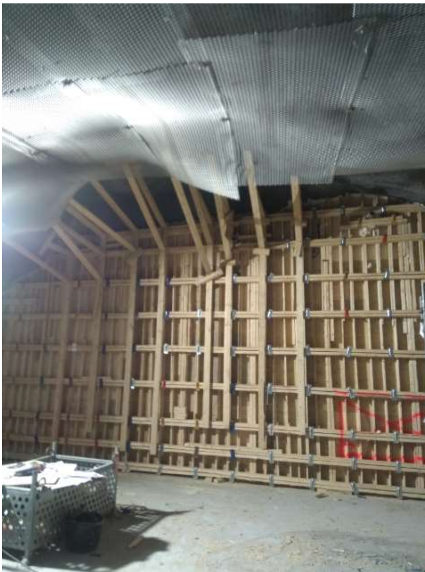
Kuva 9. Kaitaan metroaseman valmis kappaletavaramuotti.
