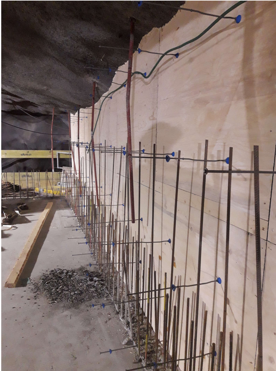
Kuva 1. Kappaletavaran työmuotti Kaitaan metroasemalla.
