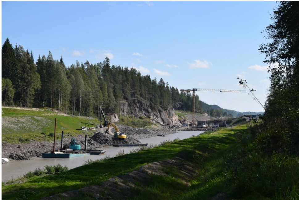
Kuva 3. Kimolan kanava rakennusvaiheessa 2.9.2019 (Hatakka 2019).
