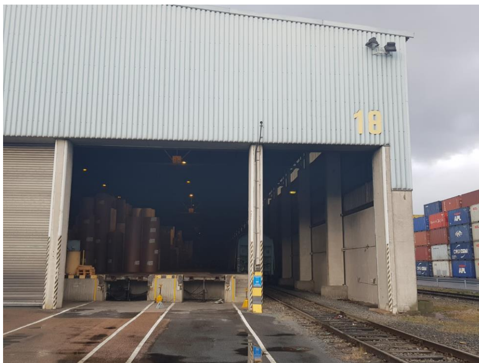
Kuva 12. Junalaiturin sisäänkäynti ja rekkojen purkupaikka.
