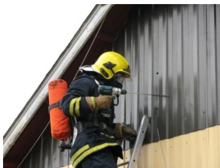
Kuva 26. Ullakkopalon jäähdytys pistosuihkuputkella rakennuksen päätykolmiosta (Mikko Halli).
