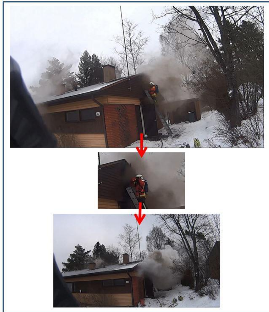
Kuva 24. Sammutusheitteen käyttö yläpohjan ontelon sammutuksessa rakennuspalossa 9.1.2017.
