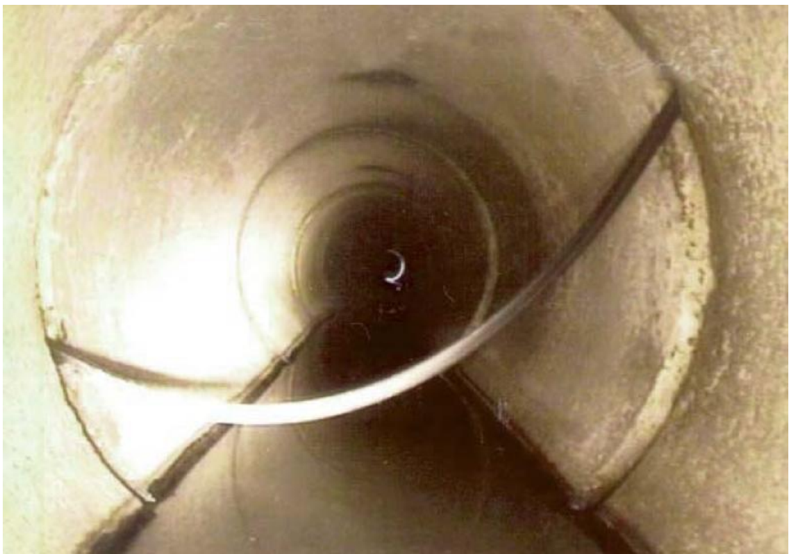
Kuva 11. Irronnut tiiviste [SFS-EN 13508-2 2011: 115]
