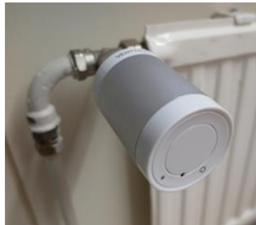
Kuva 8.3. ja kuva 8.4 Valokennolla ja paristolla varustettu langaton EnOcean lämpötila-anturi sekä EnOcean teknologialla langattomasti etäohjattava patteritermostaatti.
