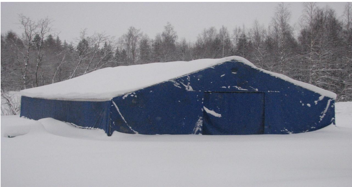
Kuva 9: Teräsheärakenteinen varastohalli rakennustyömaalla
