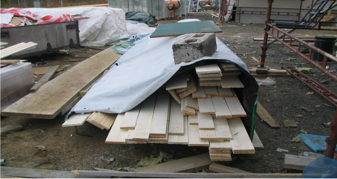
Kuva4: Kertopuupalkit varastoitu ulkoverhouslautojen kanssa. Palkit käyttökelvottomia.
