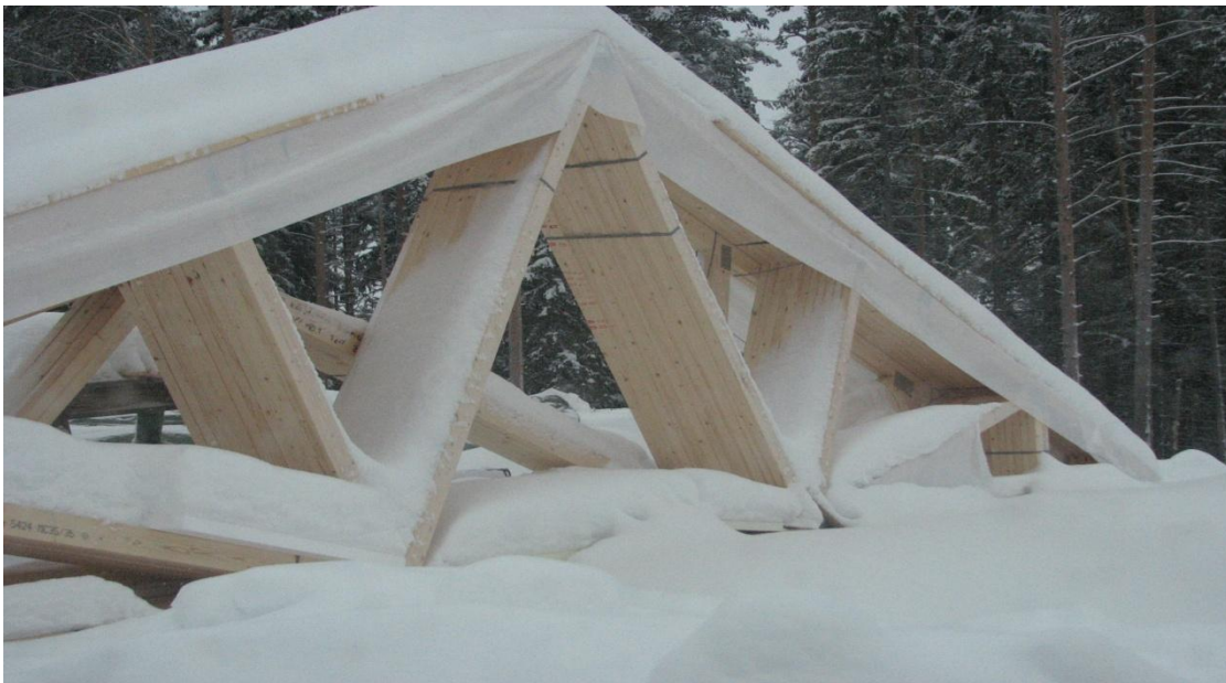
Kuva5: Kattoristikkojen varastointitapa puutteellinen.
