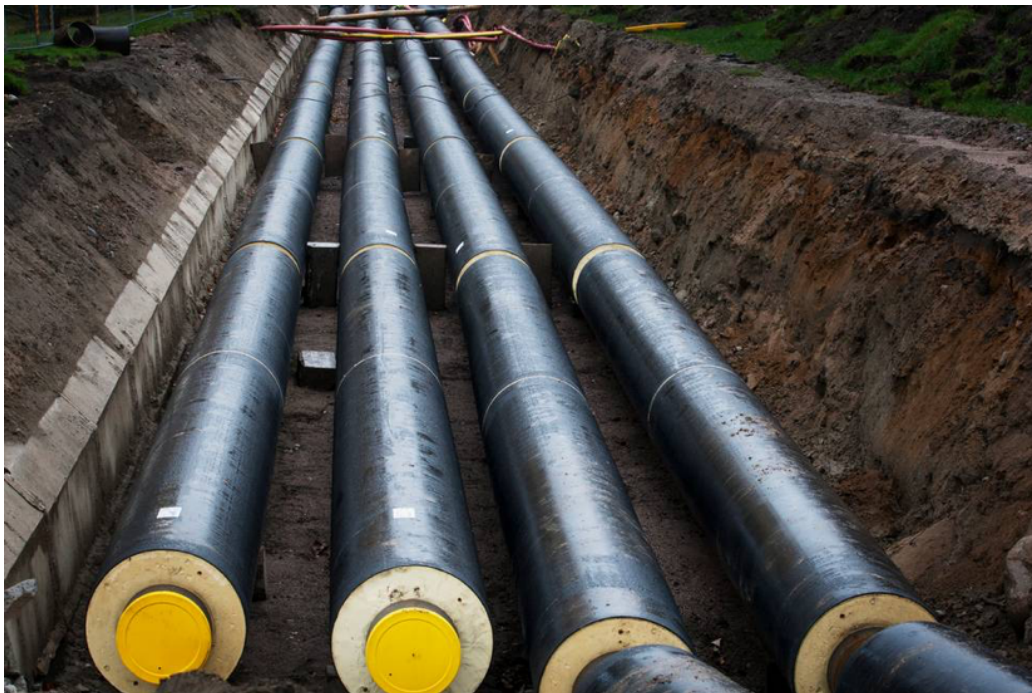
Kuva 4. Kaukolämpöputkia kaivannossa (7)
