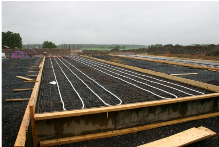
KUVA 4 Lattialämmityksen asennusvaihe (Rakennustyömaan vastaava työnjohtaja 2009).
