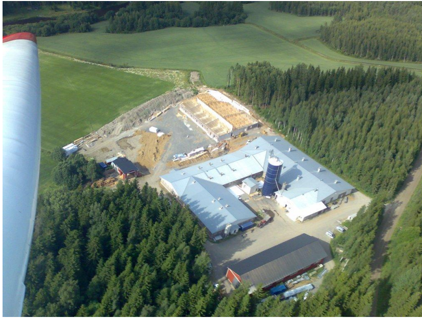
KUVA 2 Kuvassa näkyy rakenteilla olevaa laajennusosaa (Rakennustyömaan vastaava työnjohtaja 2009).
