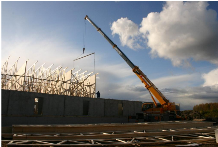
KUVA 6 Rakenteet ovat pystytysvaiheessa (Rakennustyömaan vastaava työnjohtaja 2009).
