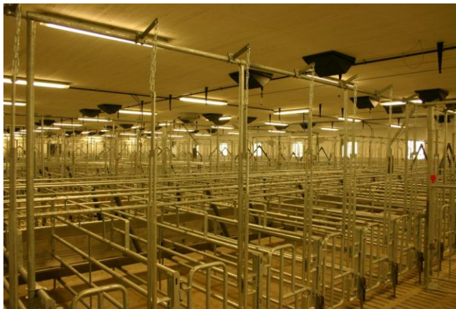
KUVA 7 Sikala on valmiiksi kalustettu (Rakennustyömaan vastaava työnjohtaja 2009).
