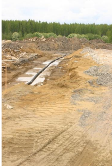
KUVA 5 Kuvassa on pohjatyöt käynnissä (Rakennustyömaan vastaava työnjohtaja 2009).
