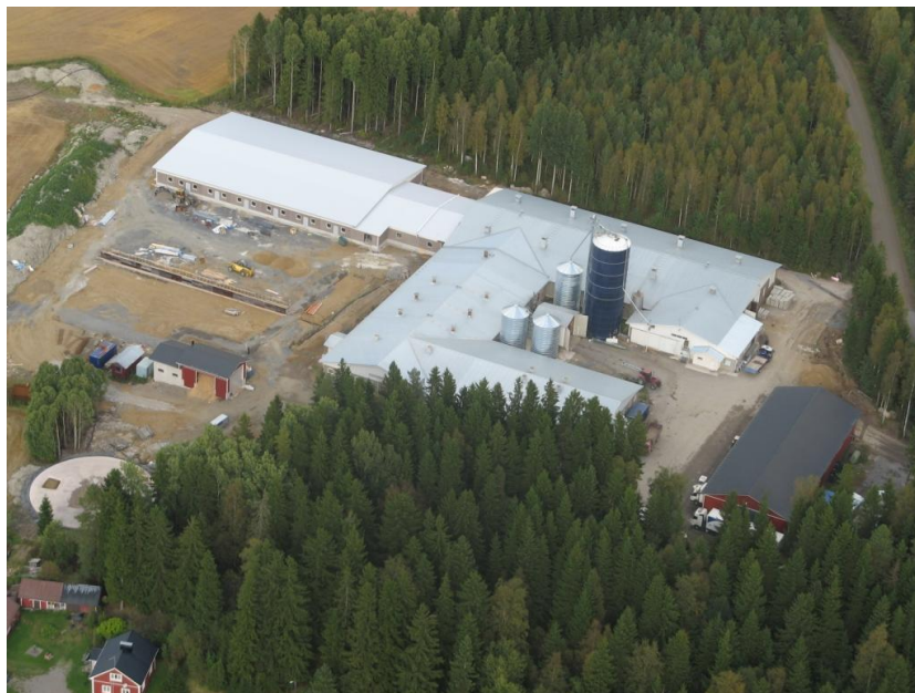
KUVA 3 Ilmakuva esimerkkitalasta. Kuvassa on valmiimpi laajennusosa. (Rakennustyömaan vastaava työnjohtaja 2009.)
