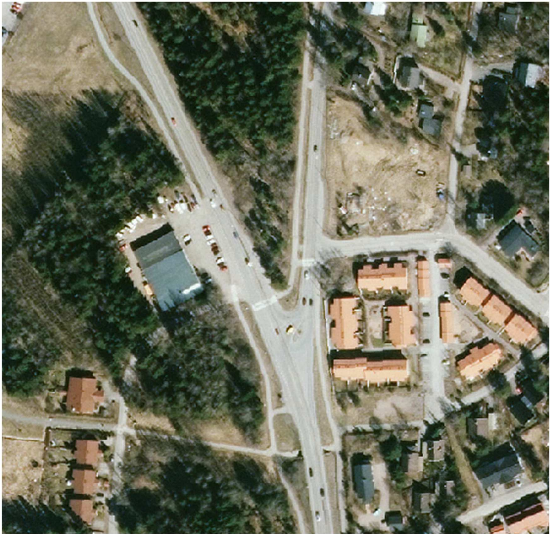
Kuva 2. Ilmakuva risteysalueesta ennen kiertoliittymän rakentamista. [9]
