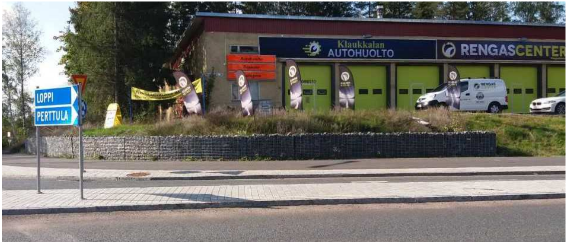
Kuva 13. Valmis kivikoriaita autohuollon pengerryksen edessä.
