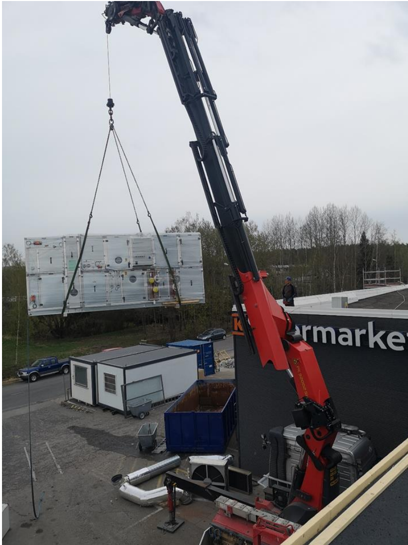
Kuva 6. Uuden ilmanvaihtokoneen nosto.
