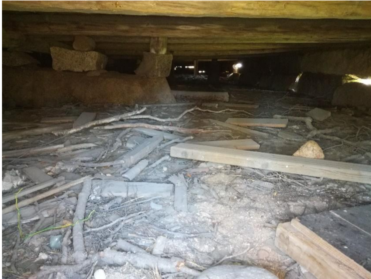
Kuva 5. Alapohja rakennuksen etelänpuoleisesta tuuletusluukusta kuvattuna.
