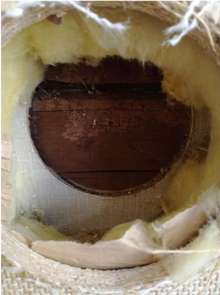
Kuva 8. Asunto-osan ulkoseinän avaus.
