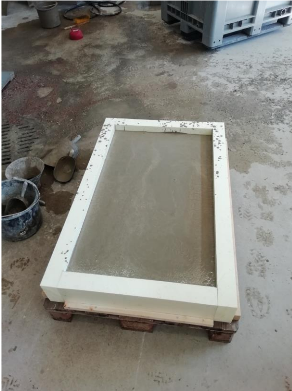
KUVA 19. Juuri valettu kosteuslaatta
