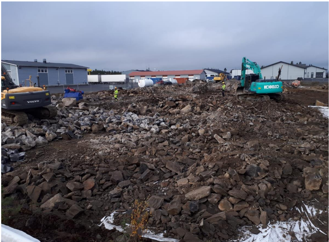
Kuva 7. Kallion louhintatöitä tontilla.
