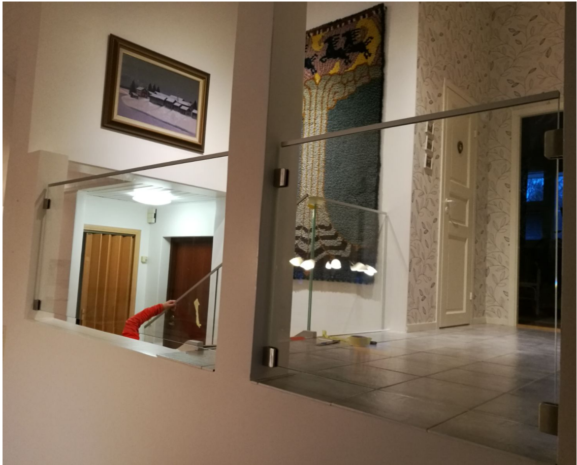
Kuva 9. Ylätasanteen lasisten tasokaiteiden toteutus CL-kiinnikkeillä
