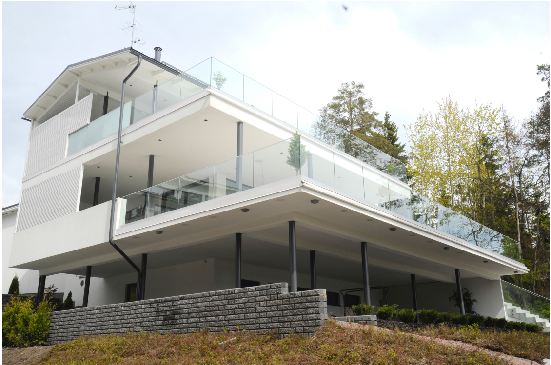
Kuva 7. Ulkoterassin lasikaiteet RR-profiililla, Helsinki Jollas
