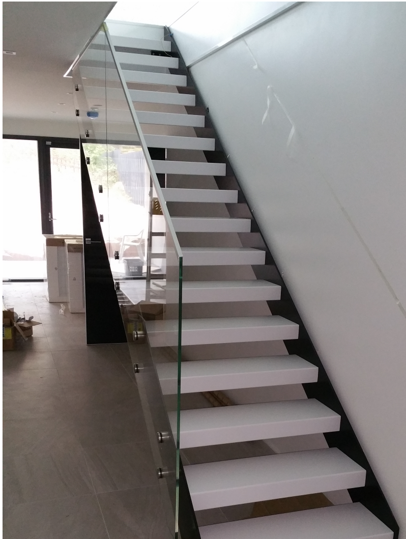
Kuva 4. AA-portaat Espoon Kaitaalla, yksityiskohteessa
