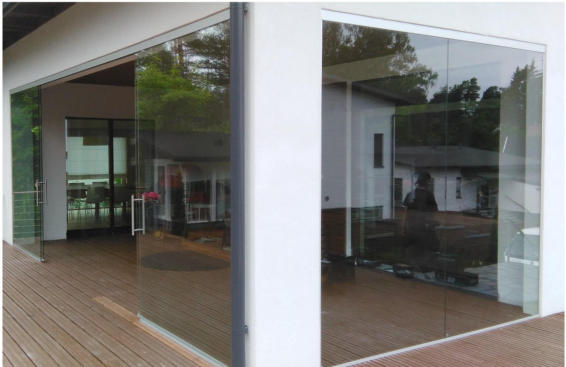
Kuva 10. Terassin kiinteä lasiseinä yhdistettynä keskeltä aukeaviin liukulasioviin
