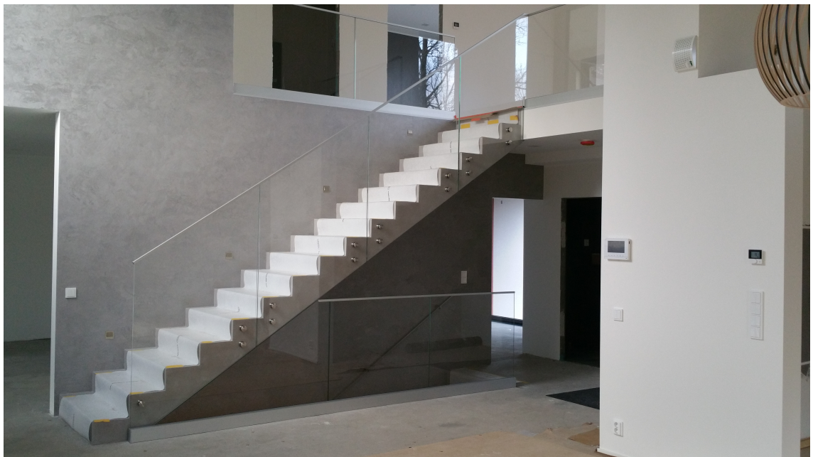
Kuva 8. Sisäportaikon DT-nousukaiteet betoniportaan kylkeen kiinnitettynä ja RR top –tasokaiteet sekä ylä- että alatasanteen porraskokkojen reunoilla, Helsinki Oulunkylä
