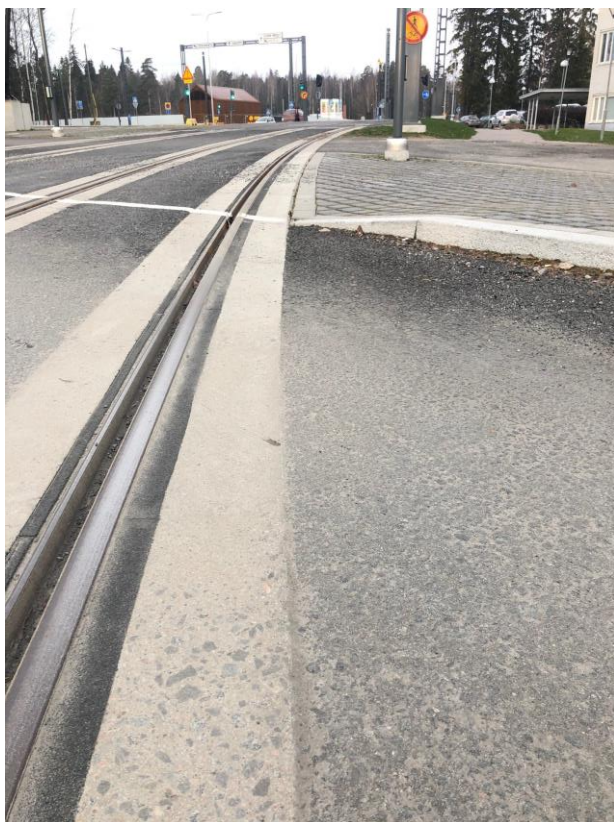
(KUVA 2.) Reunakivilinja radan lähellä
