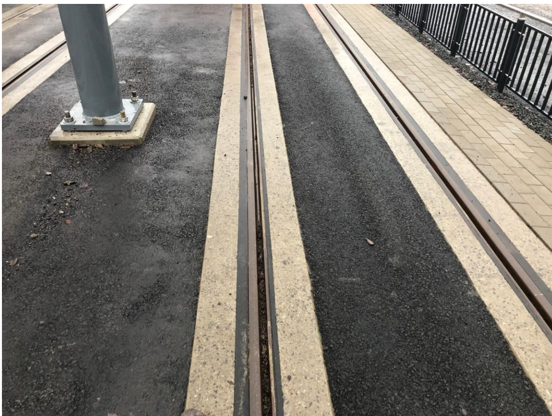
KUVA 3. Raiteet ja pylväasperustus Hervannassa.
