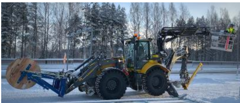
KUVA 4. Lännen Kaivin 8800K Raitiotietyömaalla (Kunnossapitoallianssi n.d.)
