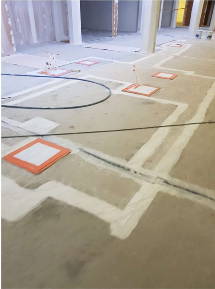
KUVA 8. Betonilaattojen saumojen tiivistys
