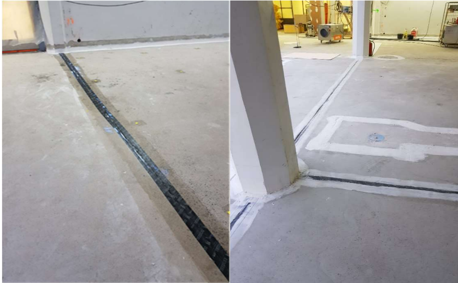
KUVA 10. Liikuntasauvojen tiivistäminen butyylinauhalla
