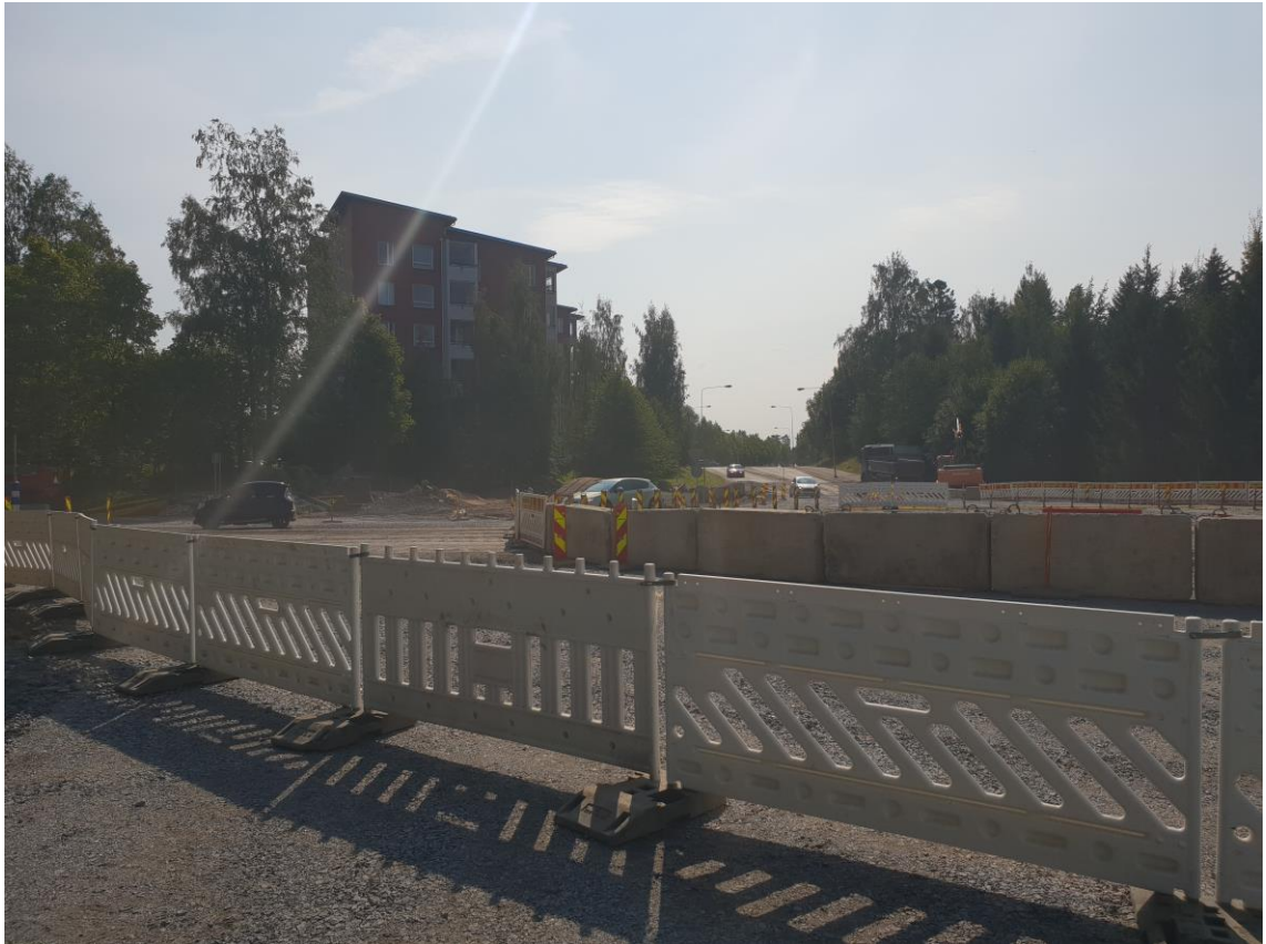
Kuva 10. Ketjuilla toisiinsa liitetyjä elementtejä suojaamassa kiertoliittymässä työskenteleviä kiveyksen asentajia
