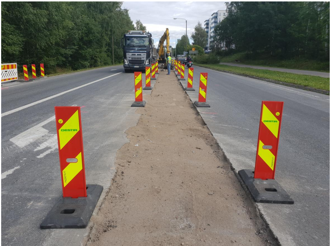
Kuva 3. Sulkupylväät erottamassa päällysteenreunaa
