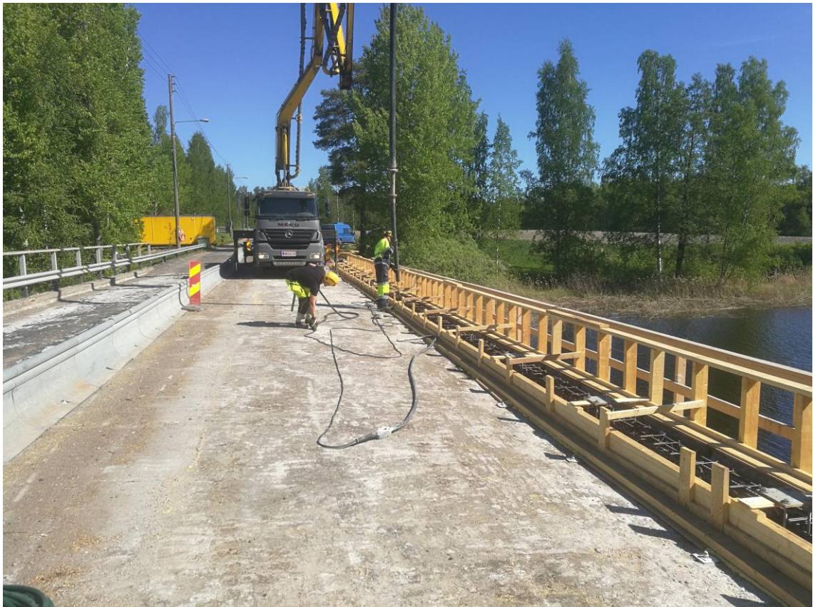
Kuva 12. Mini-Guard erottamassa liikennettä työskentelyalueesta siltatyömaalla.
