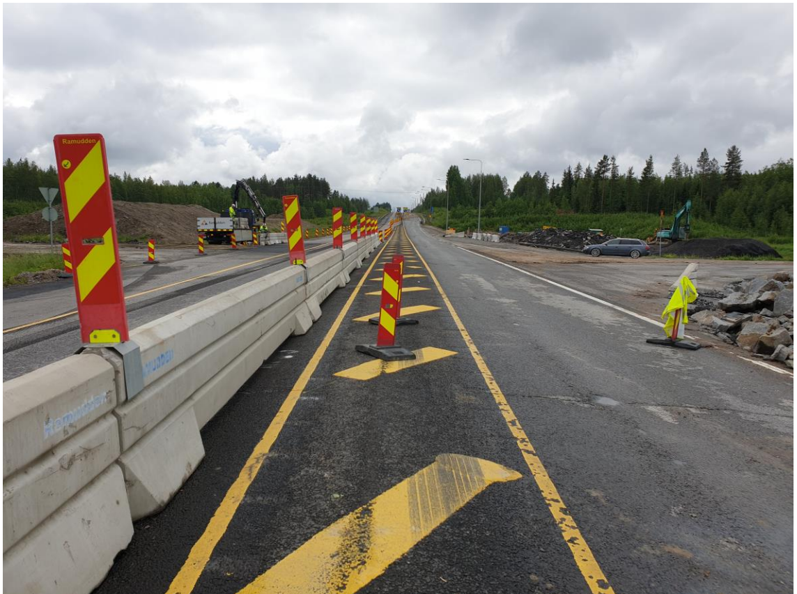
Kuva 11. GP-link betonikaide asennettuna. Taustalla asennus käynnissä HIAB-kuorma-autolla
