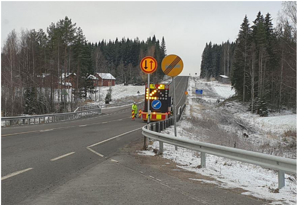
Kuva 13. TMA suojaamassa sillankorjausta, VT-4.
