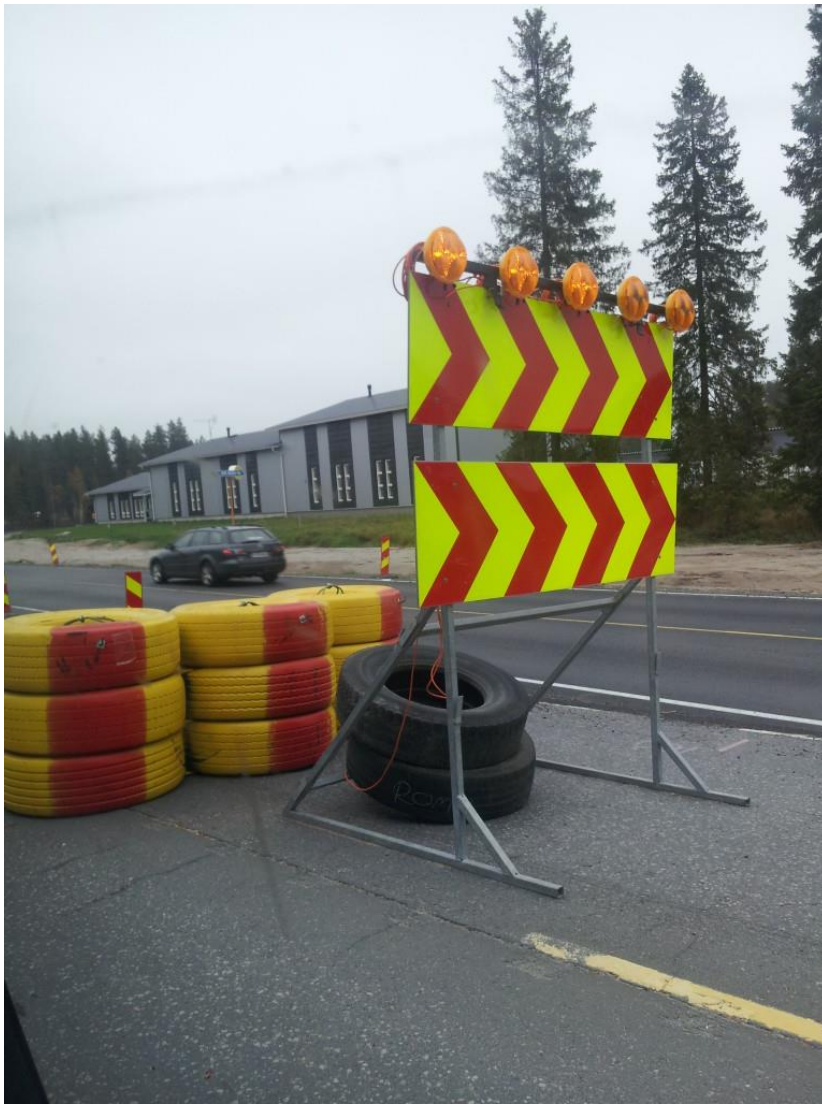
Kuva 9. Nuolikuviollinen sulkuaita suuntavilkuilla ja kuorma-auton renkaista pinotulla lisäpainolla. (Elpac Oy)
