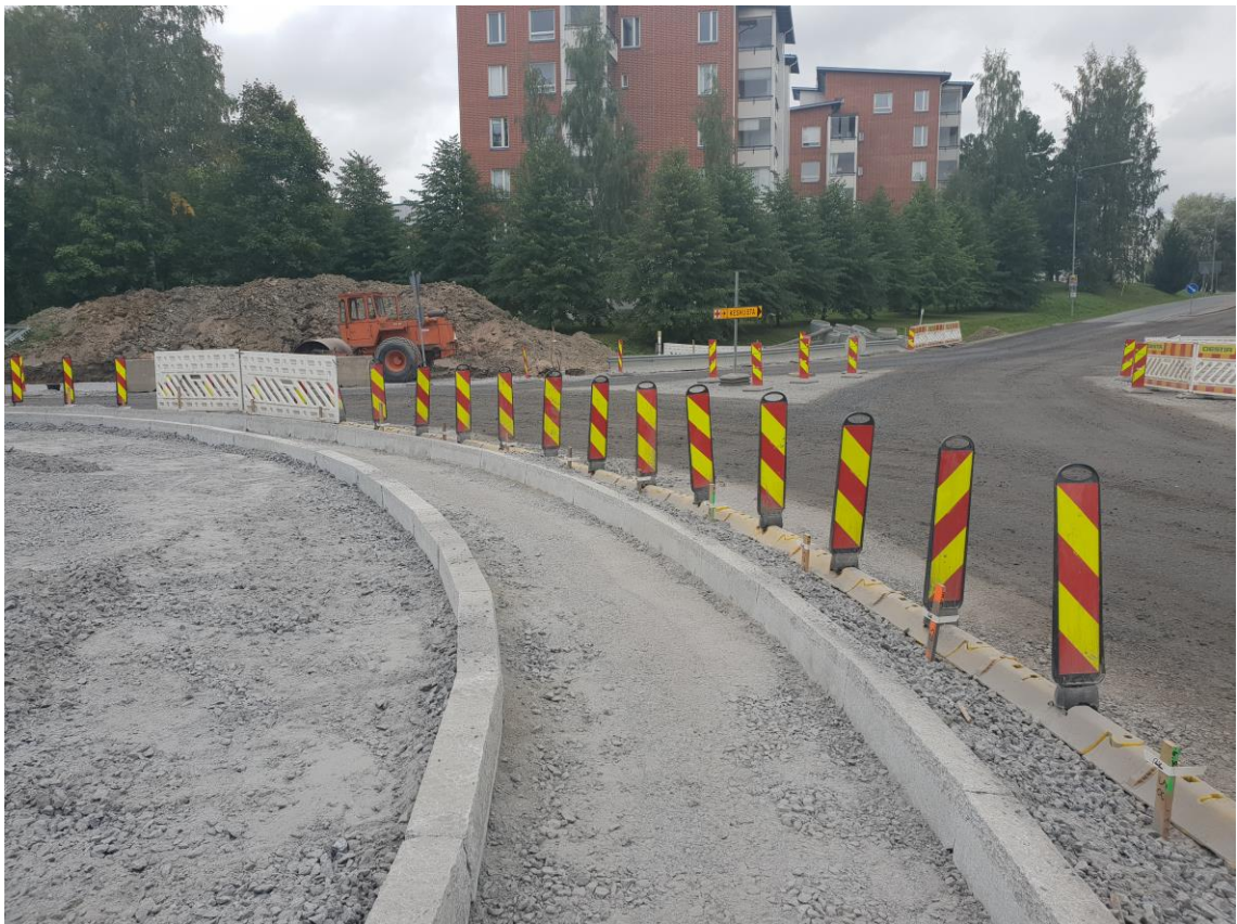
Kuva 4. Tornado Flex mallinen taipuva sulkupylväs
