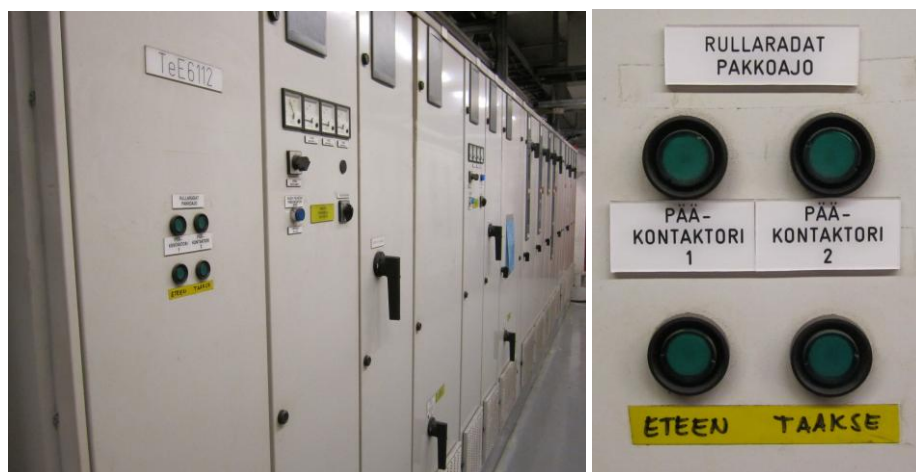
KUVIO 18. Pakko-ohjauspainikkeet kentän 1 ristiyhteyttäkaapin oveassa.
