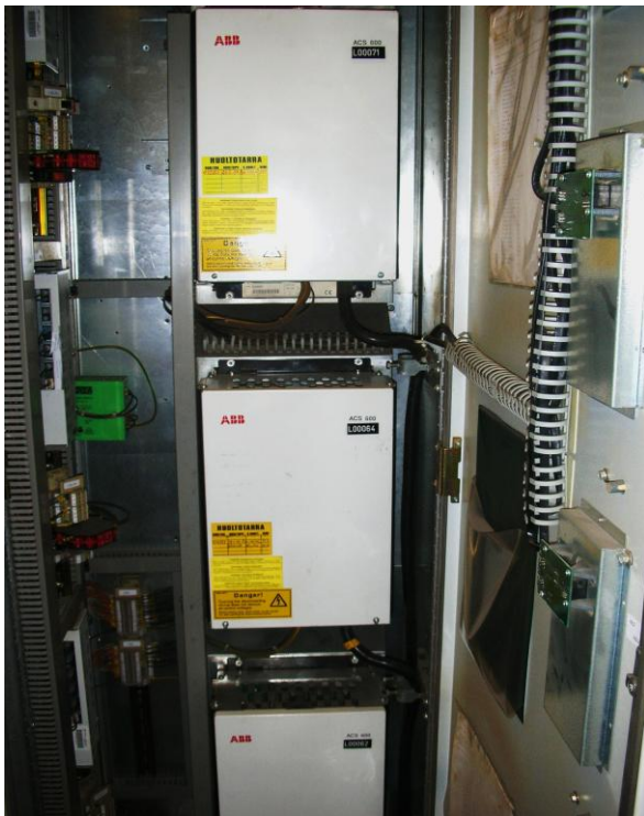
KUVIO 10. Kolme vaihtosuuntausmoduulia ABB:n vakiokaapissa.
