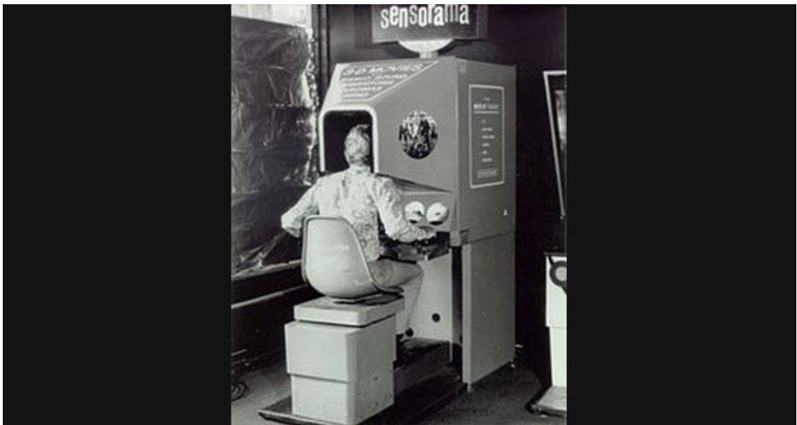
Kuva 1. Sensorama VR-laitte. (Virtualspeech. 2019.)
