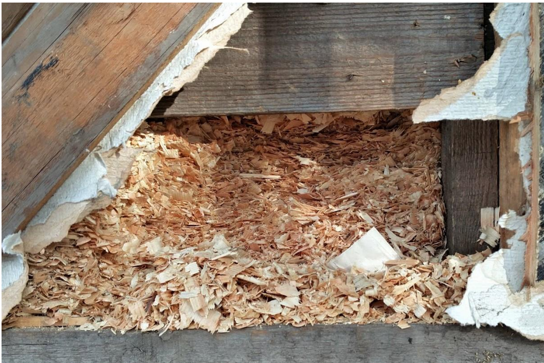
KUVIO 9. 70 vuotta vanhaa, kuivaa ja puhdasta purueristettä. (Kuva: Sally Sirviö)
