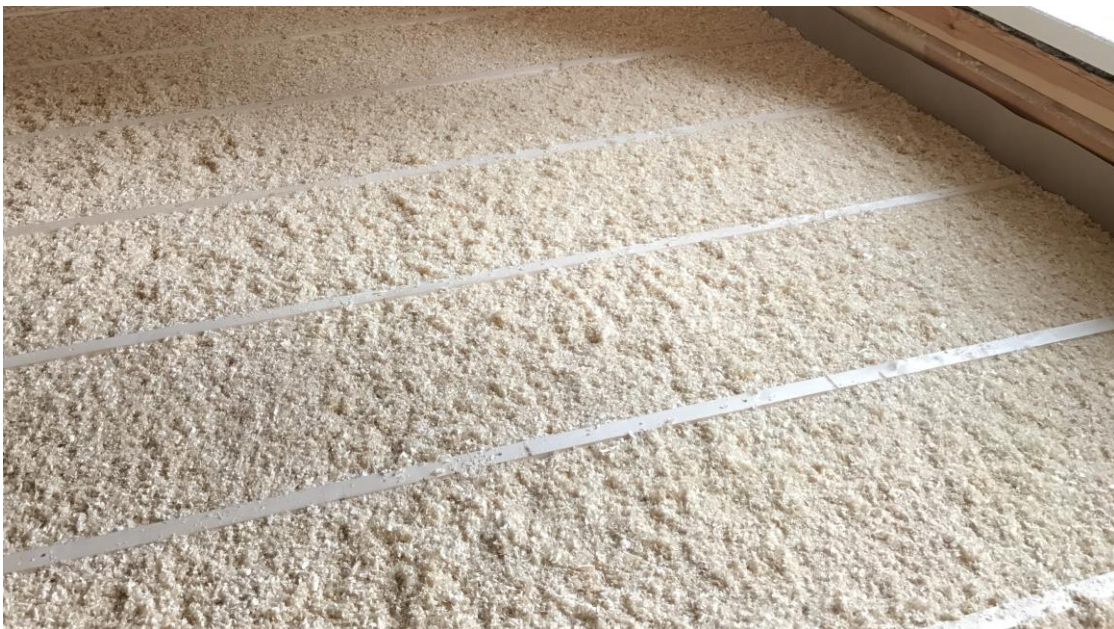
KUVIO 10. Ehta-eristettä alapohjassa (Ehta-talot Oy, viitattu 19.11.2019)
