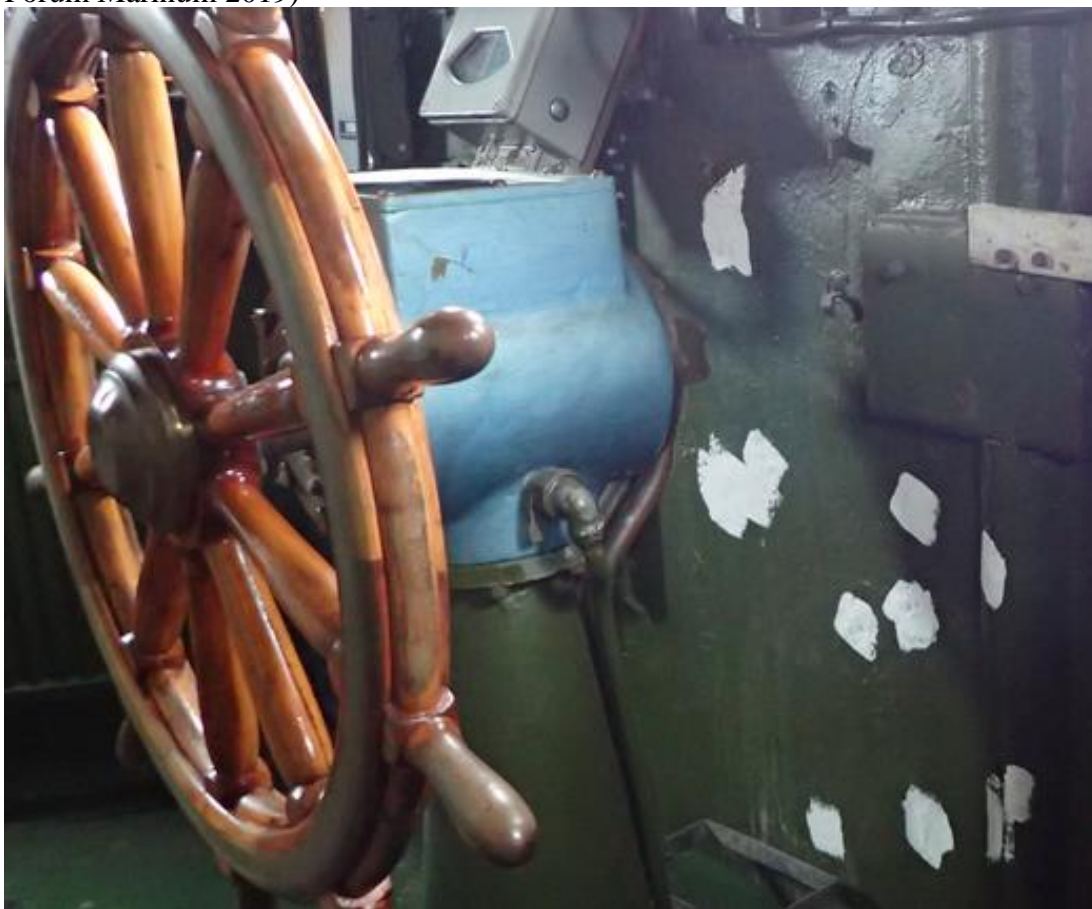
Kuva 8. Asbestieristeiden vauriokohtien kapselointi liimamassalla. (Pekka Mattila, Forum Marinum 2019)
