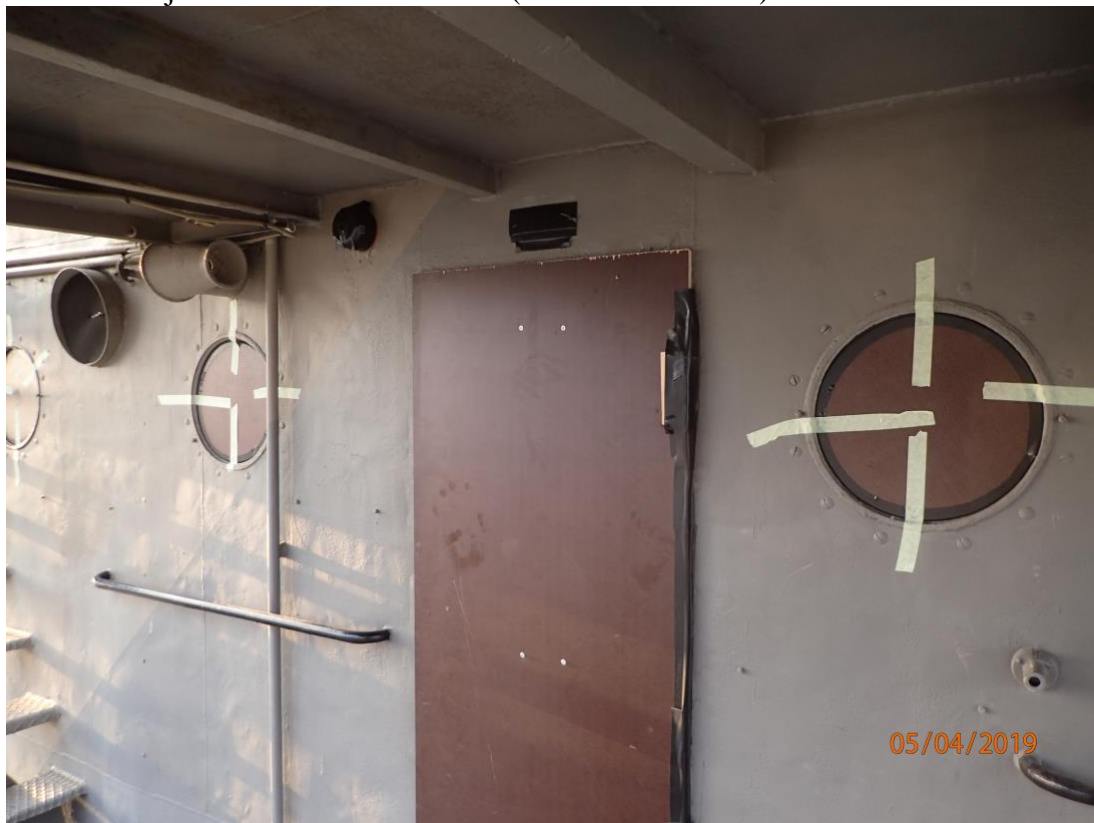
Kuva 3. Suojaustöitä ennen telakointia.(Ilkka Mattila 2019)
