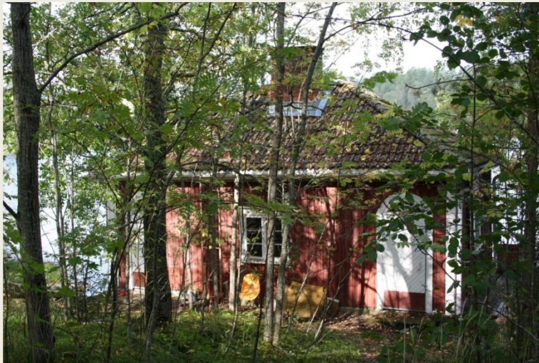
Kuva 31 Saunarakennus sijaitsee idyllisellä puuston taustoittamalla Kirkkojärven rannalla. MRT/2019.
