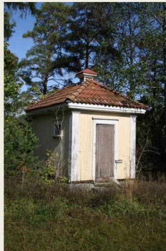
Kuva 30 Päärakennuksen läheisyydessä sijaitseva ulkokäymälä on alkuperäisessä asussaan, sähköjä myöten. MRT/2019.
