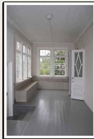
Kuva 5 Pääsisäänkäynnin tuore kunnostus. MRT/2019.
