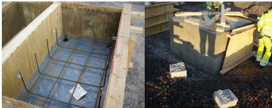
Kuva 12. Vasemmanpuoleisessa kuvassa tärinäeristys asennettu ja oikeanpuoleisessa kuvassa valmis antura.
