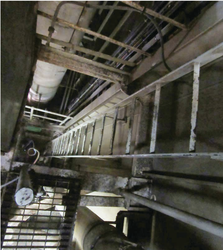
Kuva 1. Päästömittaukset tehdään laivan korsteeneista. (kuva: Elias Altarriba 2019).
