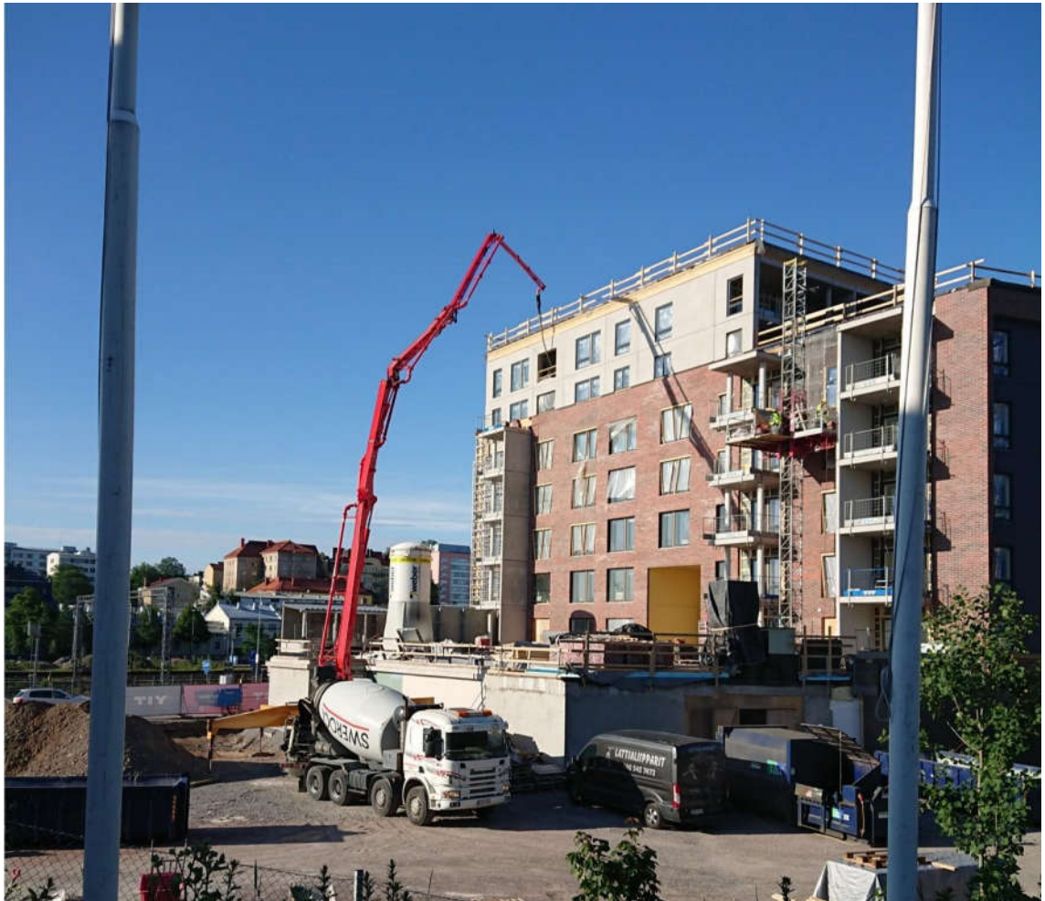
Kuva 5. Kylpyhuone betonimassan pumppaus. (YIT Suomi Oy 2019).
