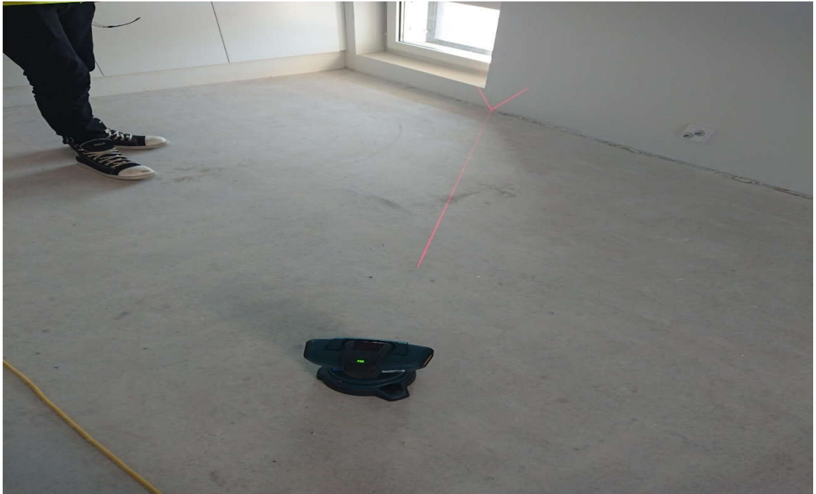
Kuva 8. Valupinnan tasaisuuden laadunvalvontaa (YIT Suomi Oy 2019).
