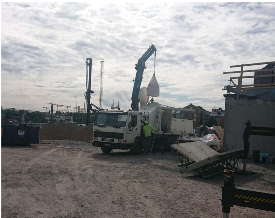
Kuva 6. Kuivientilojen kipsimassan sekoitus ja pumppaus. (YIT Suomi Oy 2019).
