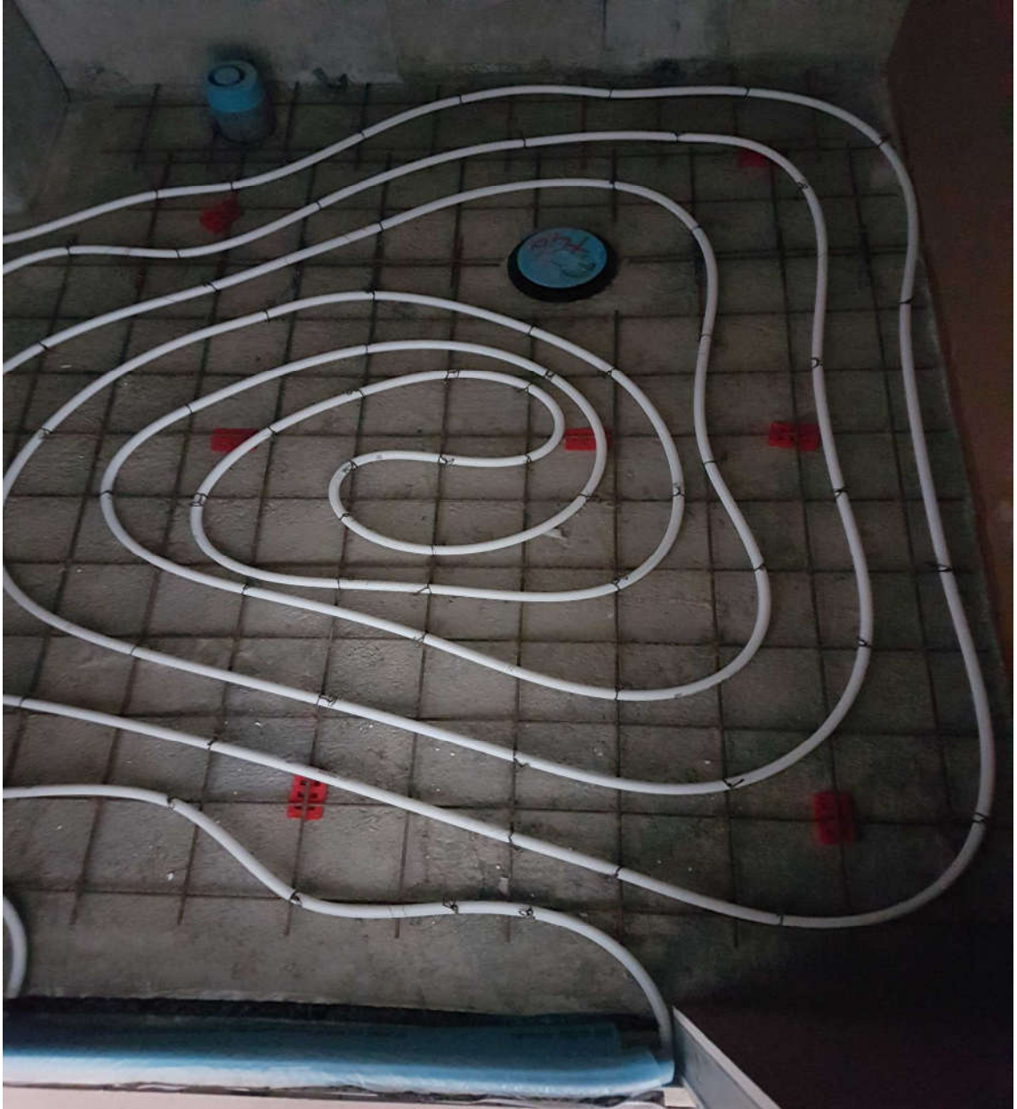
Kuva 7. Kylpyhuone valmiina pintalattiavaluun. (YIT Suomi Oy 2019).
