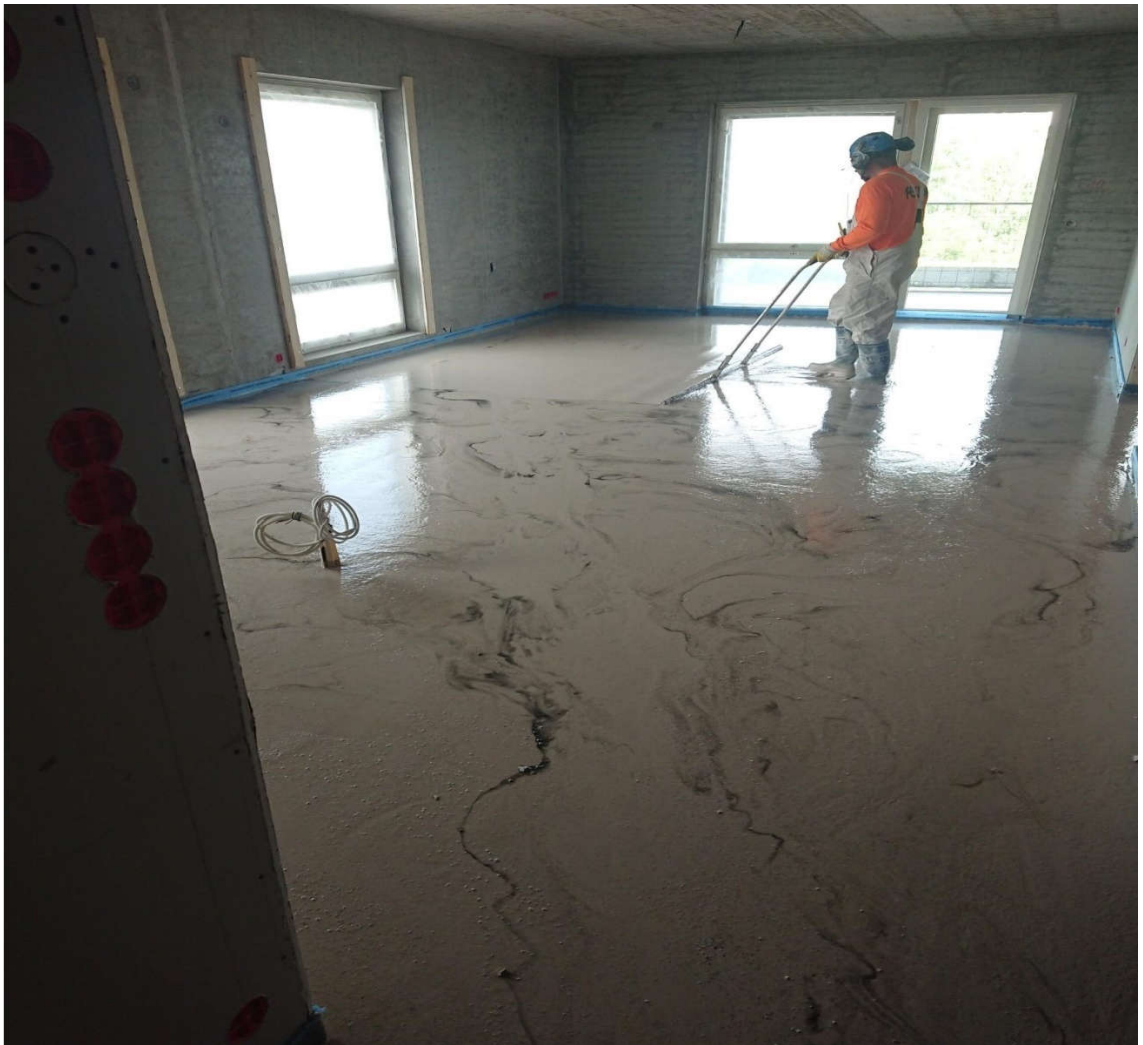
Kuva 11. Kipsin tasoitustyö. (YIT Suomi Oy 2019).
