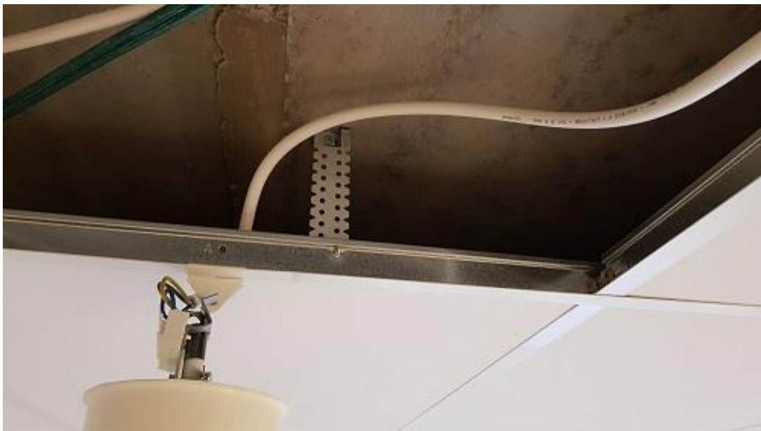
Kuva 13. Korjattu valaisimen kiinnitys.
