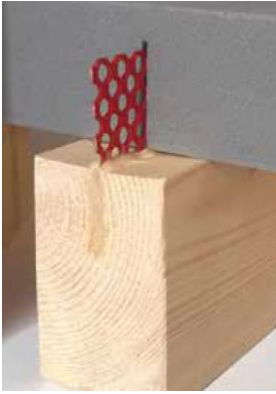
Figur 8 Skjuvförbindare med hålplåt av typen HBV (Svenskt trä, 2017, s. 93)
